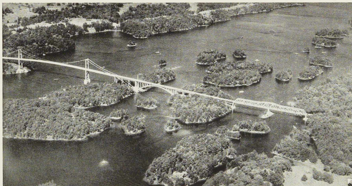
Fig. 171. Vue du pont suspendu de la passe canadienne, du pont en arc et du pont en treillis sur le Lost Channel faisant partie du groupe d'ouvrages d'art constituant le pont international des Mille-Iles entre le Canada et les Etats-Unis.
