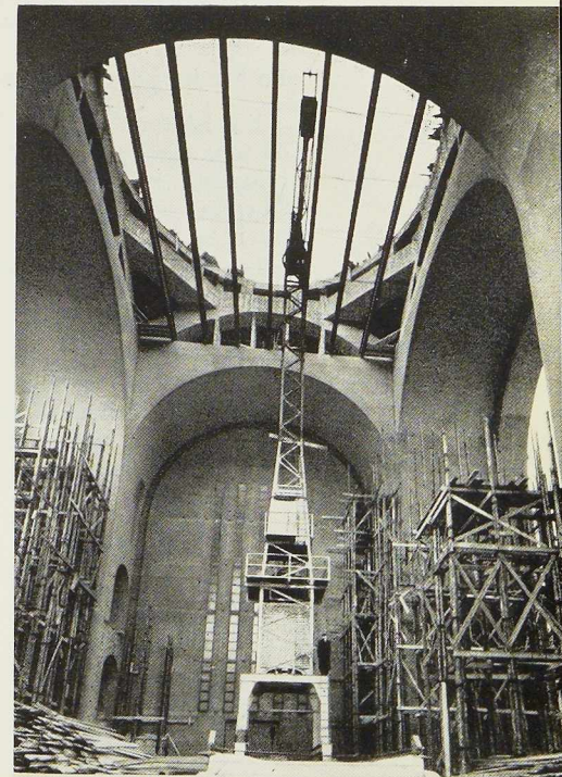
Fig. 189. Vue d'ensemble de la poutraison du plancher de travail qui se trouve à plus de 30 mètres de hauteur au-dessus du niveau du rez-de-chaussée.
