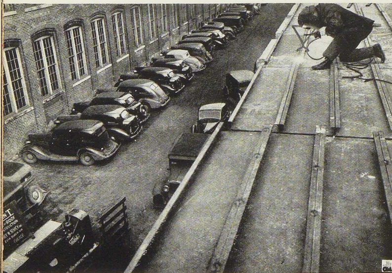
Fig. 178. Vue d'une toiture métallique d'un type nouveau construite aux Etats-Unis par la firme H. W. Schick de Chicago. Cette toiture consiste en éléments à nervures en tôles, posés sur la poutraison en acier et soudés entre eux. L'espace entre les nervures est ensuite rempli avec du béton. L'économie réalisée par ce type de construction est estimée à 50 % du coût des travaux. La photographie représente les nouvelles toitures, soudées au moyen d'électrodes International Electric Co. , des usines de la Link-Belt Co. de Chicago.
