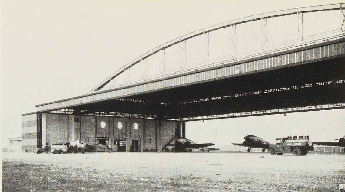
Fig. 163. Vue d'une partie du nouveau hangar. On note les cinq portes métalliques effacées sur le côté.
