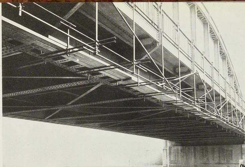
Fig. 185. Passerelle suspendue en tubes d'acier au pont Marexhe, à Liège, destinée à servir de plancher de travail.
