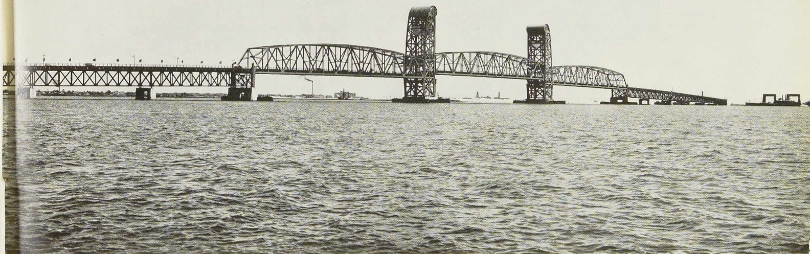
Fig. 140. Vue d'ensemble du pont Marine Parkway à New-York. La travée centrale mobile, a une longueur de 180 mètres. Ce pont a été primé au concours des plus beaux ponts de l' American Institute of Steel Construction en 1938.
