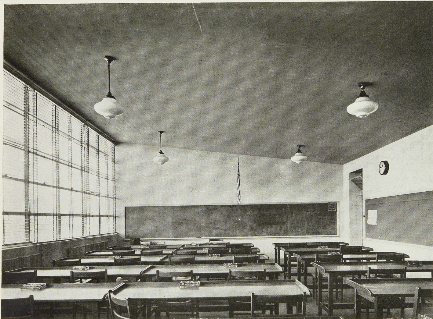
Fig. 97. Vue intérieure d'une salle de cours. Noter que le plafond, qui suit l'inclinaison des membrures inférieures des poutres, est en pente. Ce dispositif a été adopté pour empêcher la réverbération du son.
