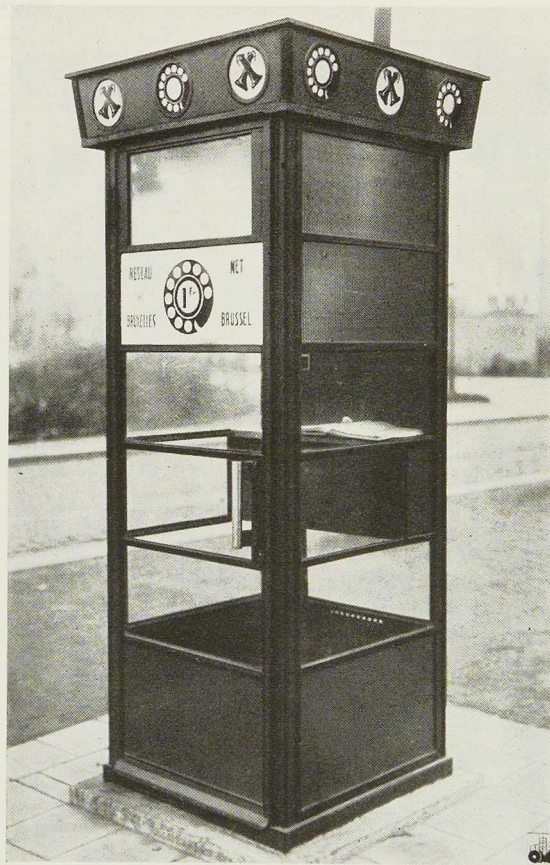
Fig. 123. Vue d'une cabine métallique de la Régie des Télégraphes et Téléphones (modèle 1938).
