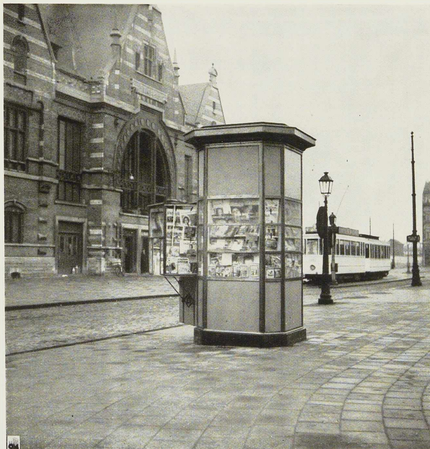
Fig. 127. Vue d'un kiosque métallique situé place Princesse Elisabeth, à Schaerbeek.
