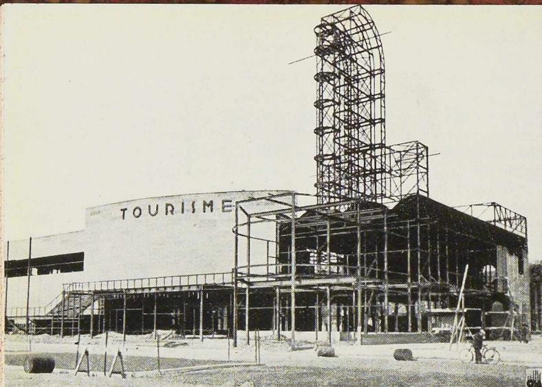
Services des Ponts et Charpentes d'Ougré-Marihaye ont fait un très gros effort pour la parfaite réussite de cette entreprise; ils ont monté un outillage spécial pour le traçage et le découpage automatique des petits éléments du portique standard, ainsi que pour le serrage mécanique des boulons.
