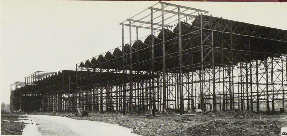
Fig. 4. Palais de la Section belge après montage des toitures.
