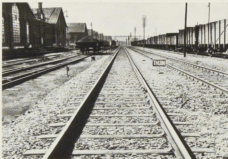
**Fig. 84.** Vue d'une voie des Chemins de fer belges équipée de traverses avec selles à crochets et cales.
