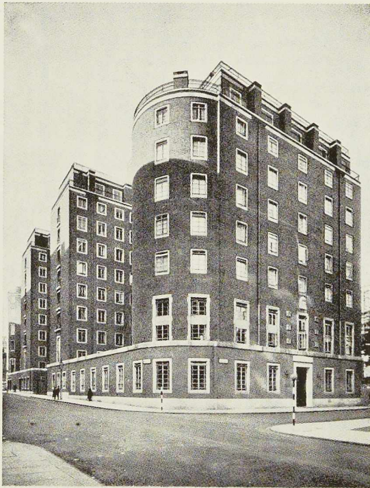
Fig. 698 (ci-contre). Vue générale du bâtiment abritant le home des infirmières et l'école de médecine.
