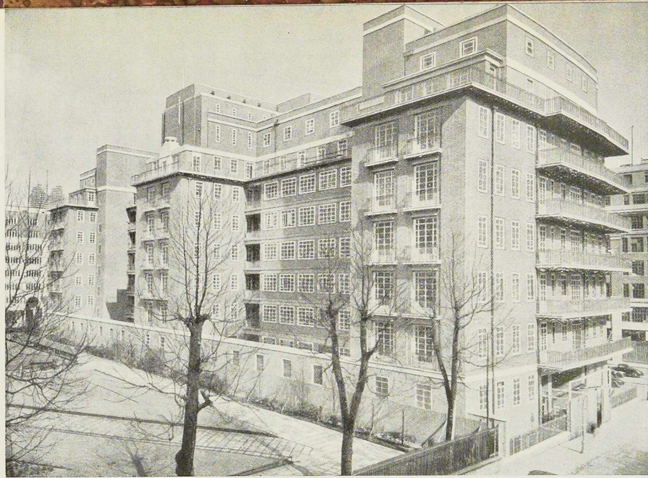
Fig. 694. Vue générale du nouvel hôpital de Westminster.
