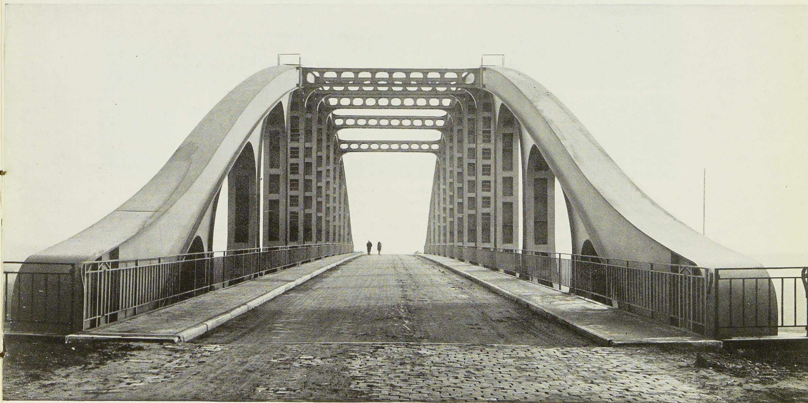
Fig. 624. Pont Vierendeel de Hermalle-sous-Argenteau.
