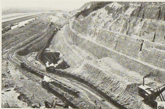
Fig. 655. Tranchée Meuse-Geer à Lanaye. Origine amont.
