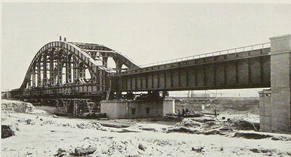
Fig. 644. Pont-rails d'Herenthals à double voie comportant une travée centrale à poutres Vierendeel de 89 m 54 de portée et deux travées d'approche en poutres à âme pleine de 33 m 20 de portée chacune.
