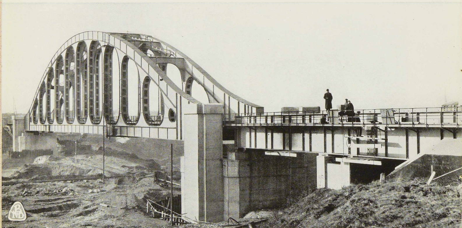
Fig. 629. Pont-rails de Gellick au-dessus du canal Albert.
