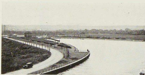
Fig. 653. Jonction du canal Albert avec la Meuse à Visé. Chenal d'accès vers l'écluse de Visé.
