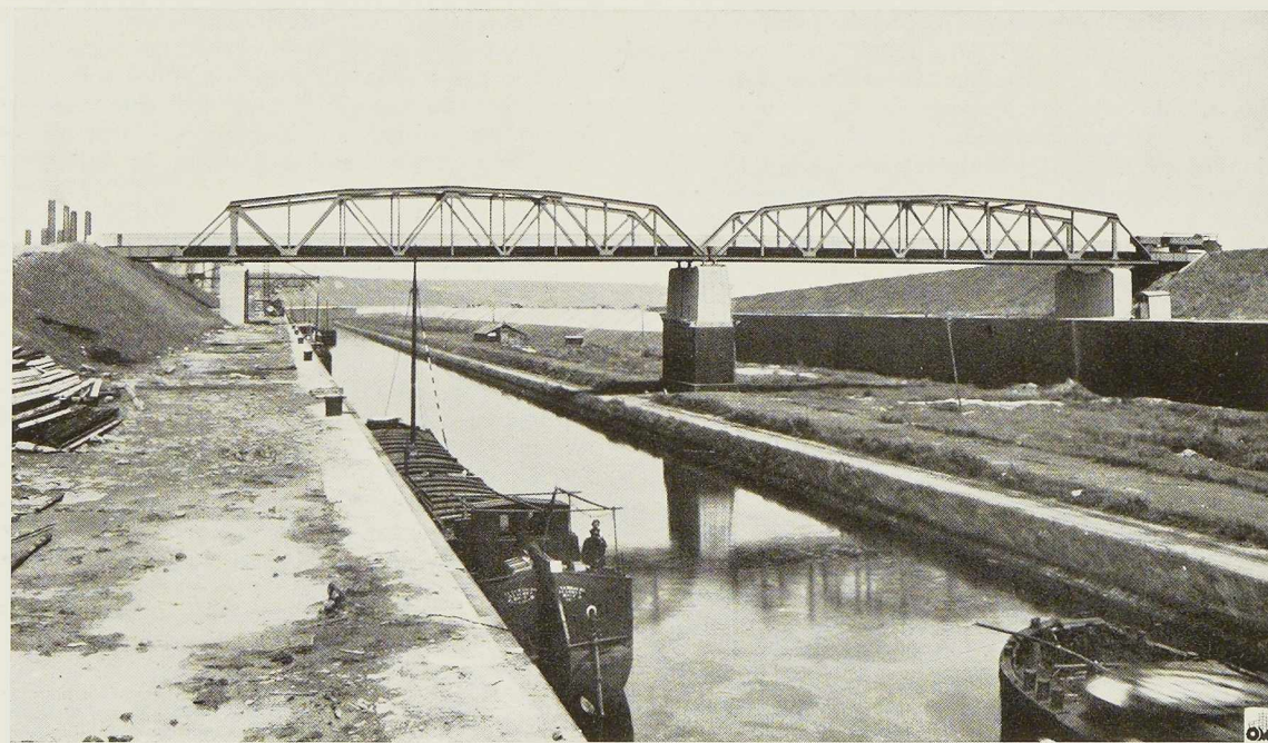
Fig. 616. Le pont-route de Lixhe comportant deux travées à poutres en treillis de 40 m 50 et deux travées d'approche de 9 m 54.
