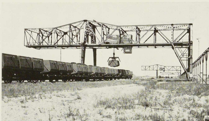
Fig. 675. Un des trois ponts-portiques de 30 mètres de portée du port charbonnier de Genk.
