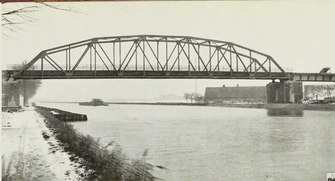
Fig. 618. Pont de Grobbendonck. La travée centrale en treillis a une portée de 54 m 95.
