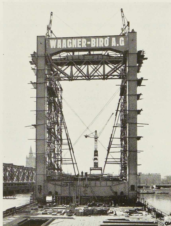
Fig. 573. Vue d'un pylône.
