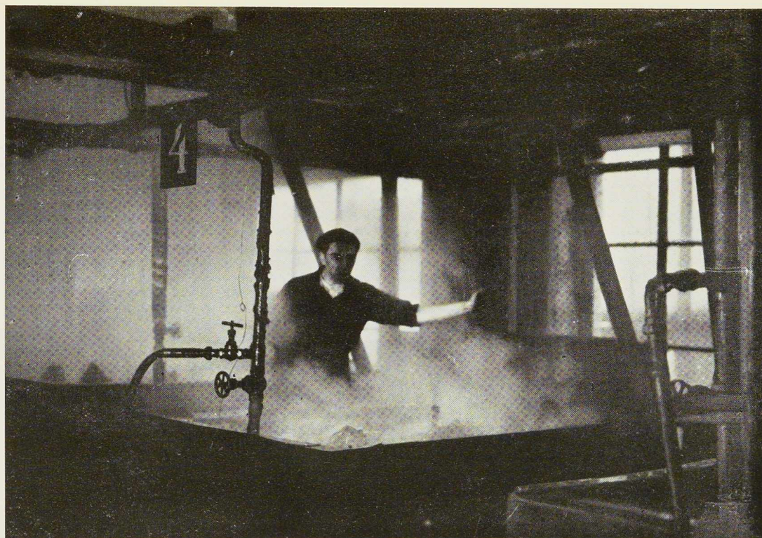
Fig. 582. Alimentation en vapeur d'une teinturerie verviétoise.
