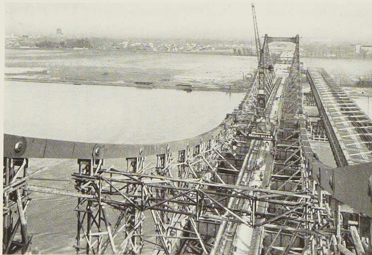
Fig. 571. Echafaudage pour le montage des chaînes.
