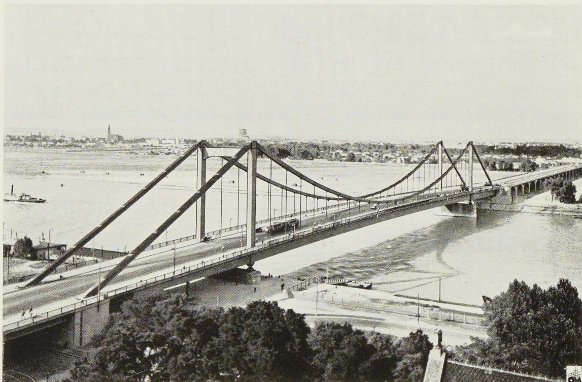
Fig. 566. Vue générale du nouveau pont « Reichsbrücke » à Vienne.
