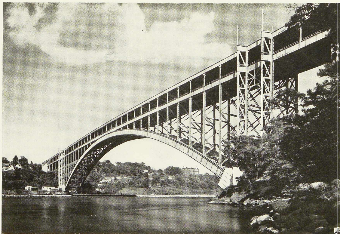
Fig. 535 et 536. Le pont Henry Hudson avant et après la pose de son deuxième tablier.
