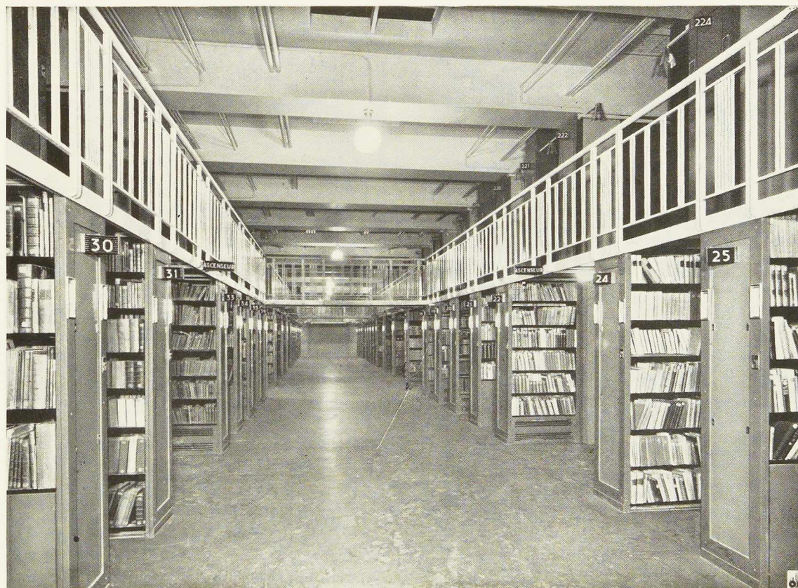
Fig. 591. Vue générale des nouveaux magasins créés en sous-sol à la Bibliothèque nationale de Paris. Ces magasins comportant deux étages de 2 m 20 chacun sont munis de rayonnages métalliques en tôle pleine.
