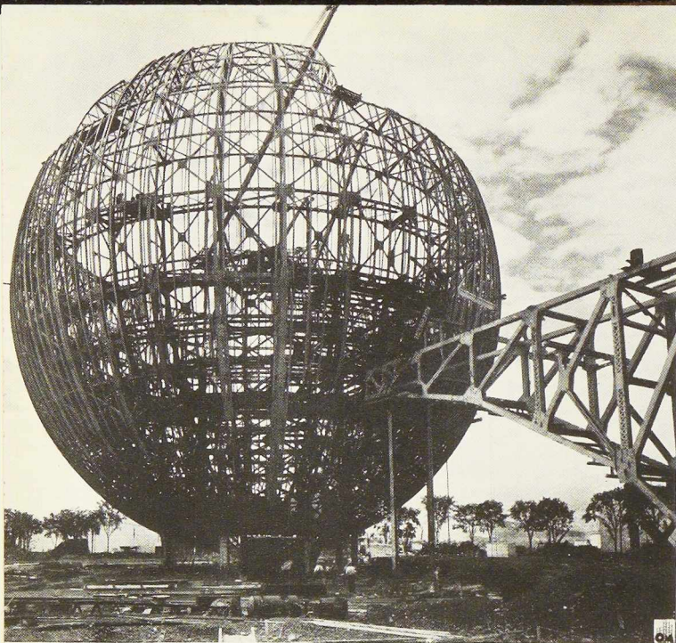
Fig. 565. L'ossature en acier de la grande sphère de 60 mètres de diamètre en voie d'achèvement.
