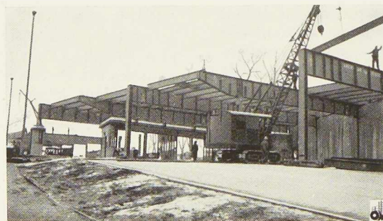
Fig. 541. Poutraison du tablier surélevé à l'entrée du plan incliné le raccordant à la chaussée, à l'extrémité Sud du pont.
