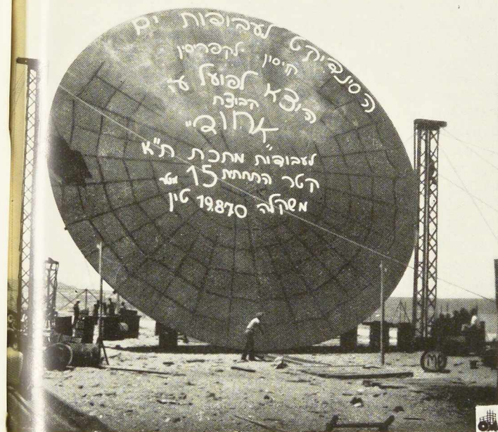
Fig. 581. Fond d'un caisson flottant de 15 mètres de diamètre et 3 m 20 de hauteur. La photographie a été prise lors du retournement de la pièce pesant 20 tonnes.
