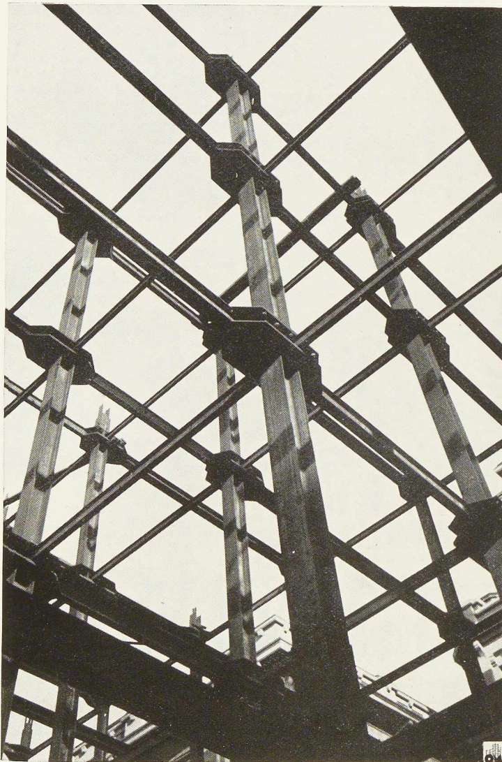
DÉTAIL DE L'OSSATURE MÉTALLIQUE DE L'INSTITUT JULES BORDET, A BRUXELLES
