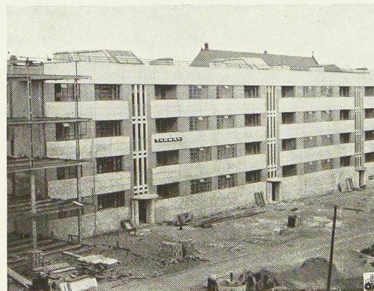
Fig. 479. Façade des bâtiments revêtue de plaques de « Contex ».
