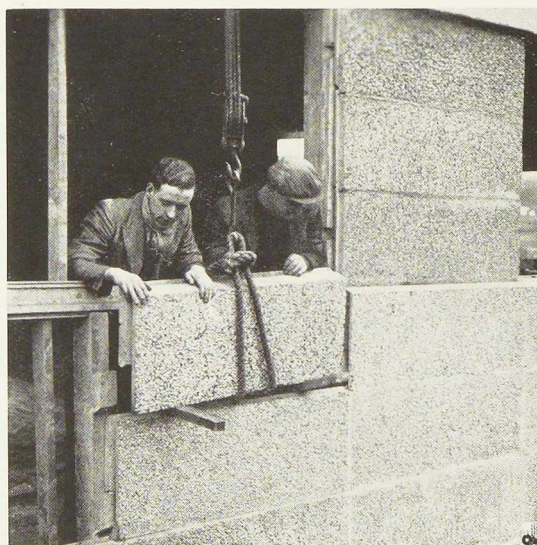
Fig. 484. Pose en façade des blocs en béton vibré coulés à l'avance.
