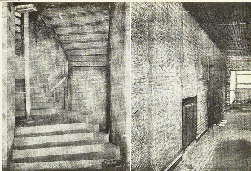
Fig. 397. L'escalier du bâtiment administratif en cours de construction. Les marches et contremarches sont en tôle d'acier.
