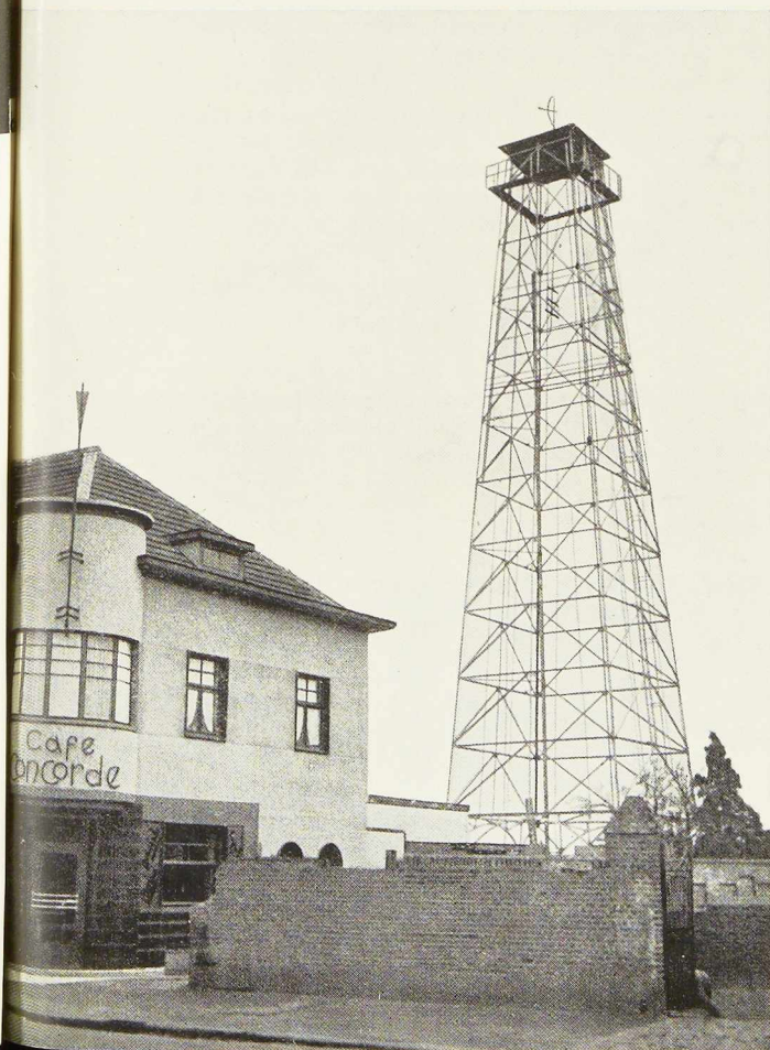
Fig. 420. Tour à cape installée à Louvain.
