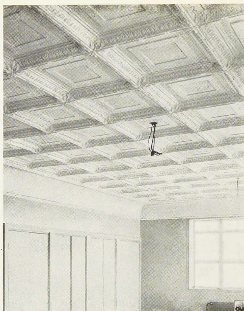
Fig. 402. Plafond, en tôle d'acier estampée, dans un des bureaux.
