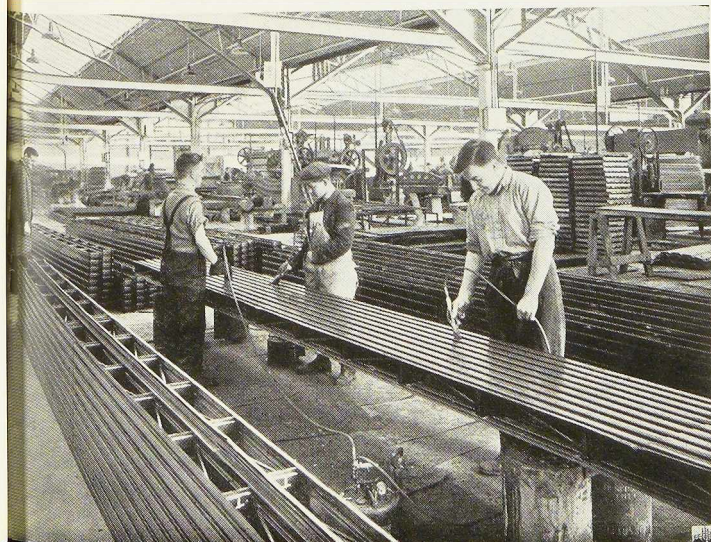
Fig. 400. Vue intérieure des ateliers de la Steel Ceilings Limited en pleine exploitation. La photographie montre, notamment, la peinture des caissons pour planchers et toitures, en tôle profilée en queue d'aronde, qui sont fabriqués en grande série dans cette usine.
