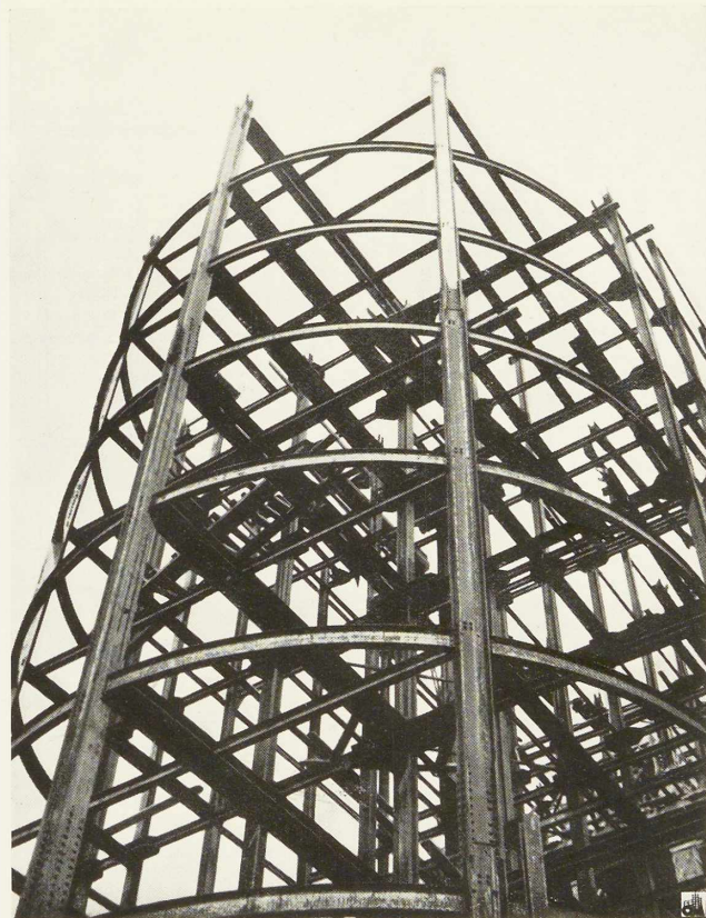
Fig. 407. Vue de l'ossature de la rotonde.
