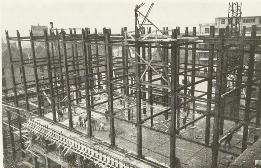
Fig. 404. Vue de l'ossature métallique en cours de construction.
