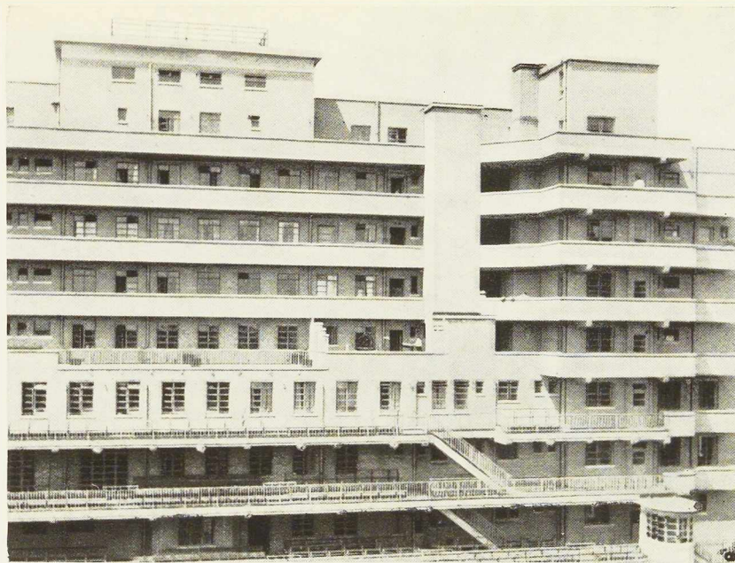
Fig. 336. Vue de la façade arrière du bâtiment. Les balcons que l'on voit aux étages inférieurs sont destinés au public assistant aux exercices pratiques des pompiers.
