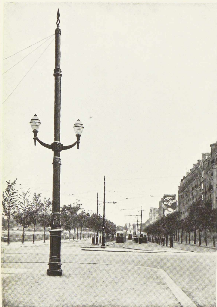
Fig. 366. Poteau tubulaire support de lignes servant également à l'éclairage urbain à Paris.
