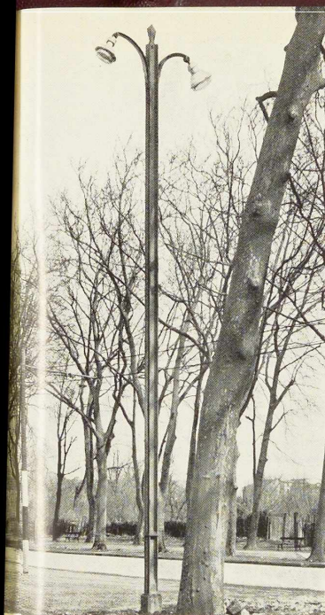
Fig. 361. Pylône en poutrelle à bourrelets BYH de 8 mètres de hauteur, installé à Grenoble.
