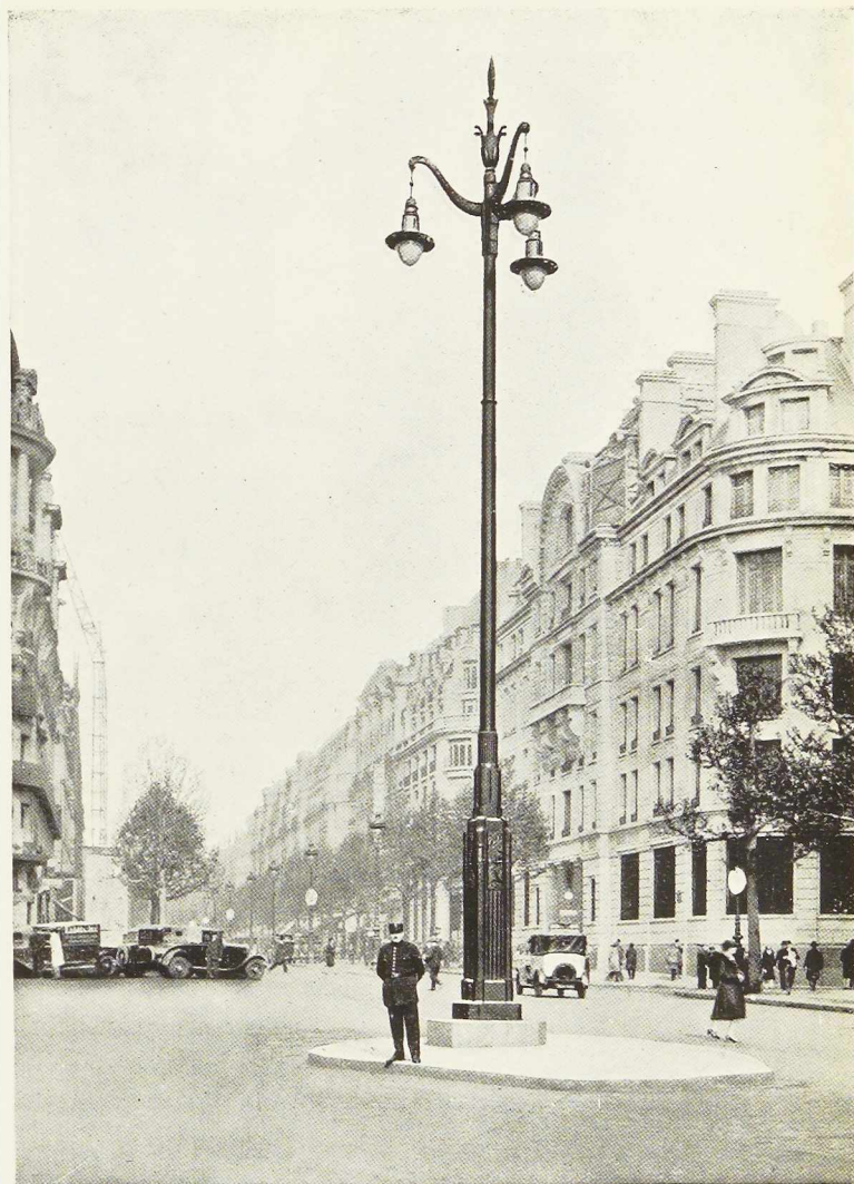
Fig. 368. Poteau tubulaire à trois feux, à Paris.
