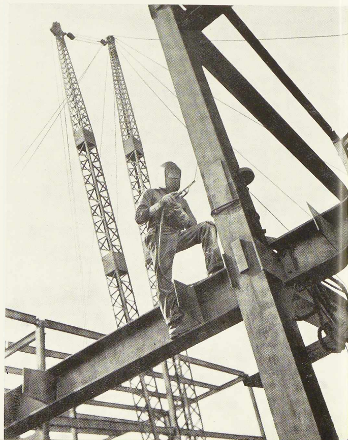
Fig. 339. Travaux de soudure au bâtiment de la Westinghouse Electric and Manufacturing Co., à Sharon (E.U.).
