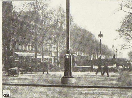
Fig. 353. Candélabre à deux feux, place de la Bastille à Paris. Le pylône a 15 mètres de hauteur et est du type « Acma » à trois tronçons ainsi que celui de la figure 354.
