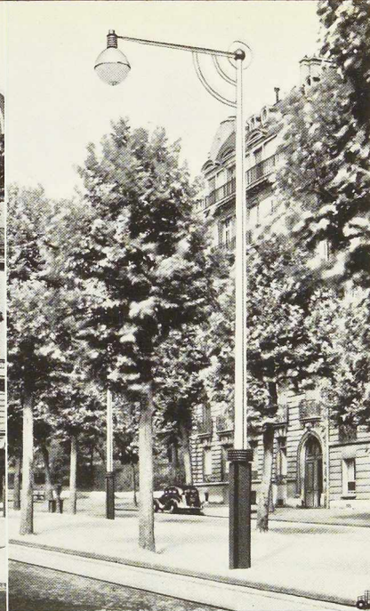
Fig. 356. Autre pylône du même type muni d'une potence en acier embouti.
