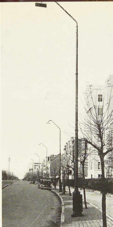
Fig. 374. Pylône tubulaire employé pour l'éclairage des routes près de Bruxelles. On notera la potence prolongeant directement le pylône tubulaire.
