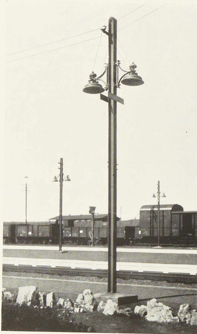
Gare de Marloie (S. N. C. F. B.) Poteaux d'éclairage en poutrelles GREY
