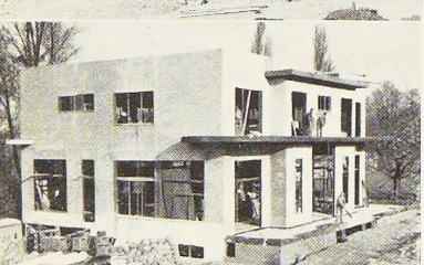
Fig. 239. Le 26 novembre 1937, on s'apprête à poser les vitres, ce qui permettra d'effectuer le parachèvement intérieur à l'abri des intempéries.
