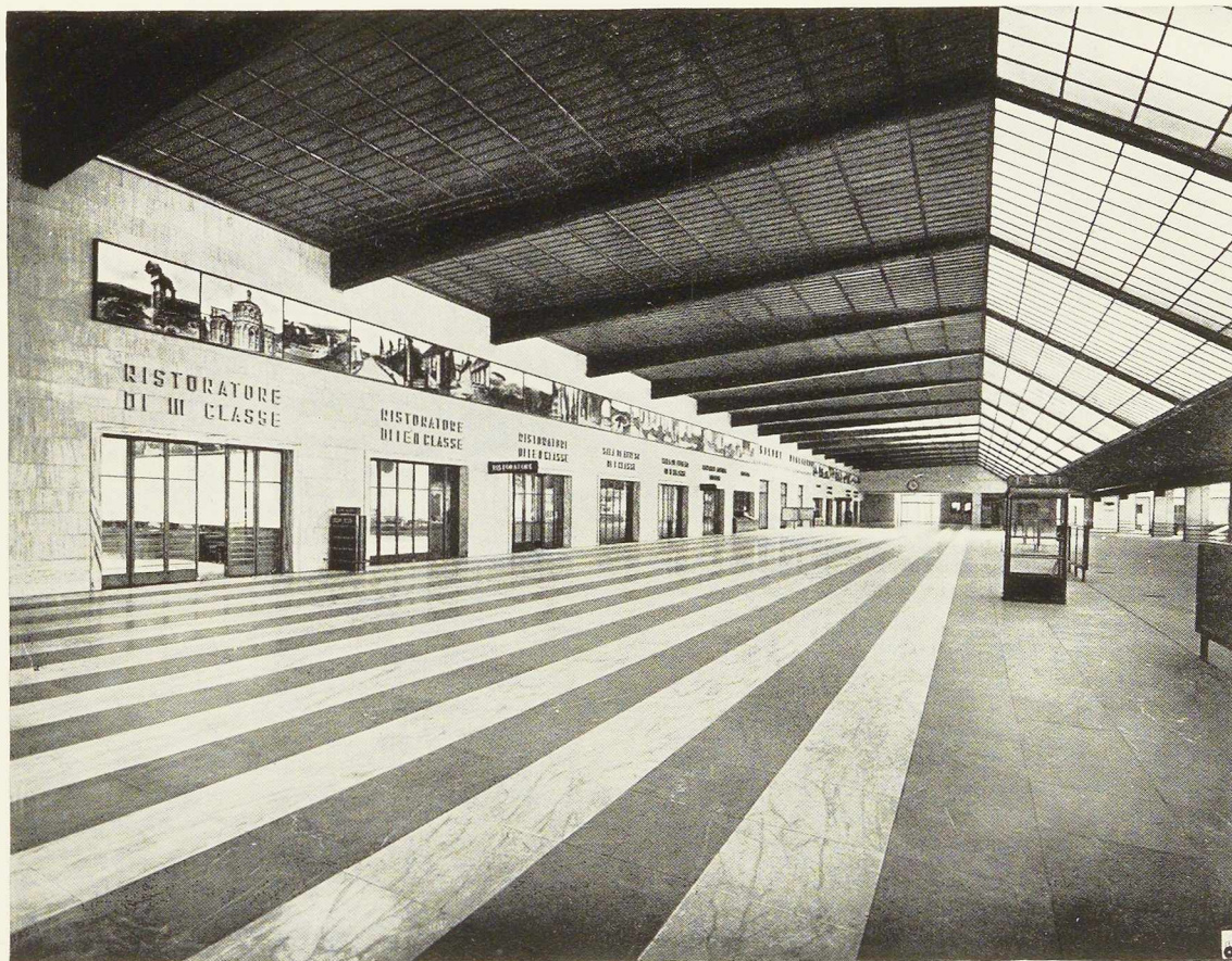
Fig. 292. Vue de la galerie et du quai de tête mesurant ensemble 105 \times 30 mètres. Les deux parties qui composent cet ensemble sont différenciées l'une de l'autre par le parement et la hauteur du plafond. On note les toitures vitrées inclinées.
