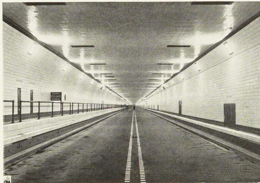
Fig. 212. Vue intérieure de la branche sud du Lincoln Tunnel.
