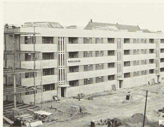
Fig. 226. Vue d'un groupe de maisons de la cité « Quarry Hills » en voie d'achèvement.
