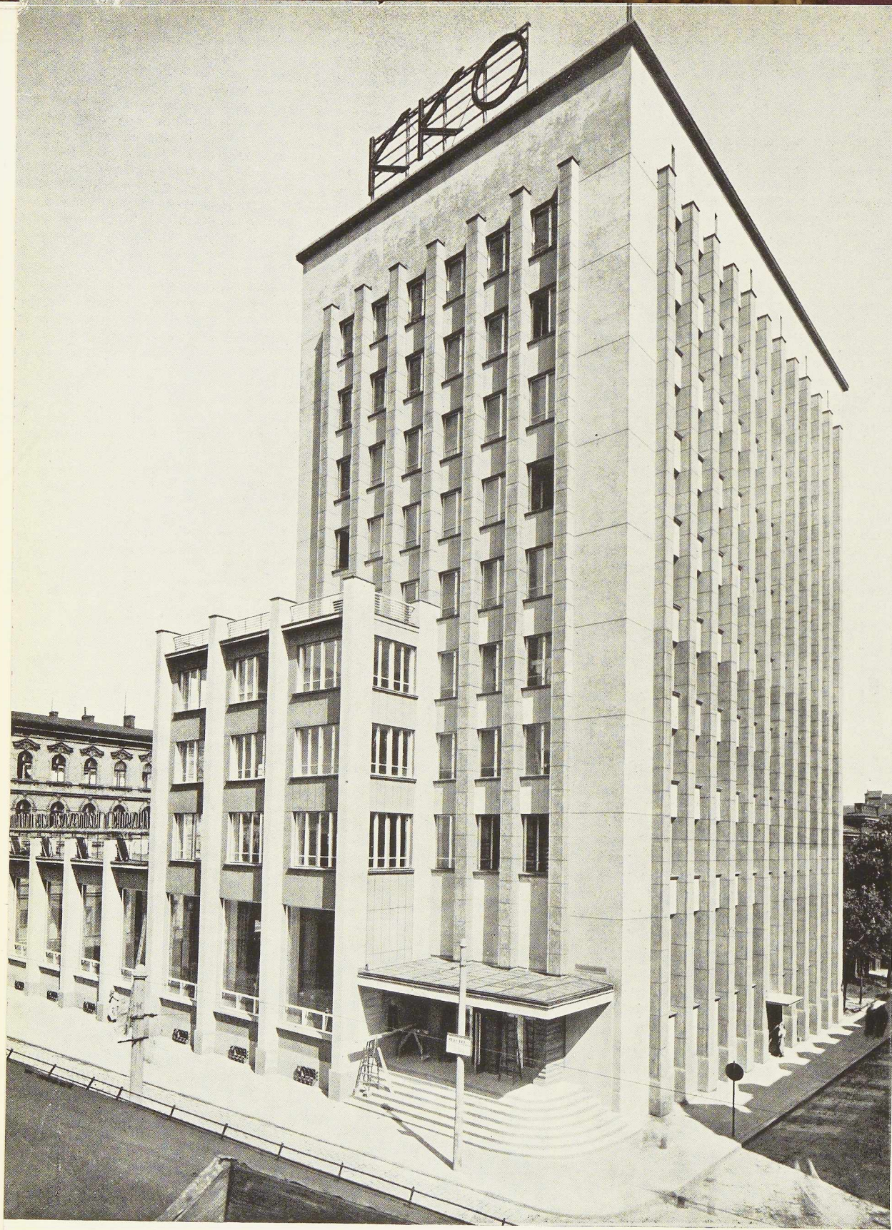
Fig. 211. Un intéressant exemple de l'architecture moderne polonaise : la Caisse d'Epargne Communale à Chorzow, entièrement construite en ossature métallique, d'après les plans du professeur S. Bryla.
