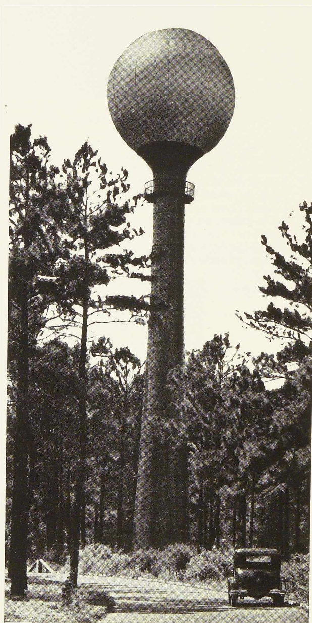
Fig. 190. La cuve métallique de ce château d'eau, construit à White Sulphur Springs (E.-U.), point culminant d'un agréable quartier résidentiel manquait certes de poésie. Une colonnade, qui n'a rien de « fonctionnel », en a fait un faux temple grec de gracieuse silhouette.
