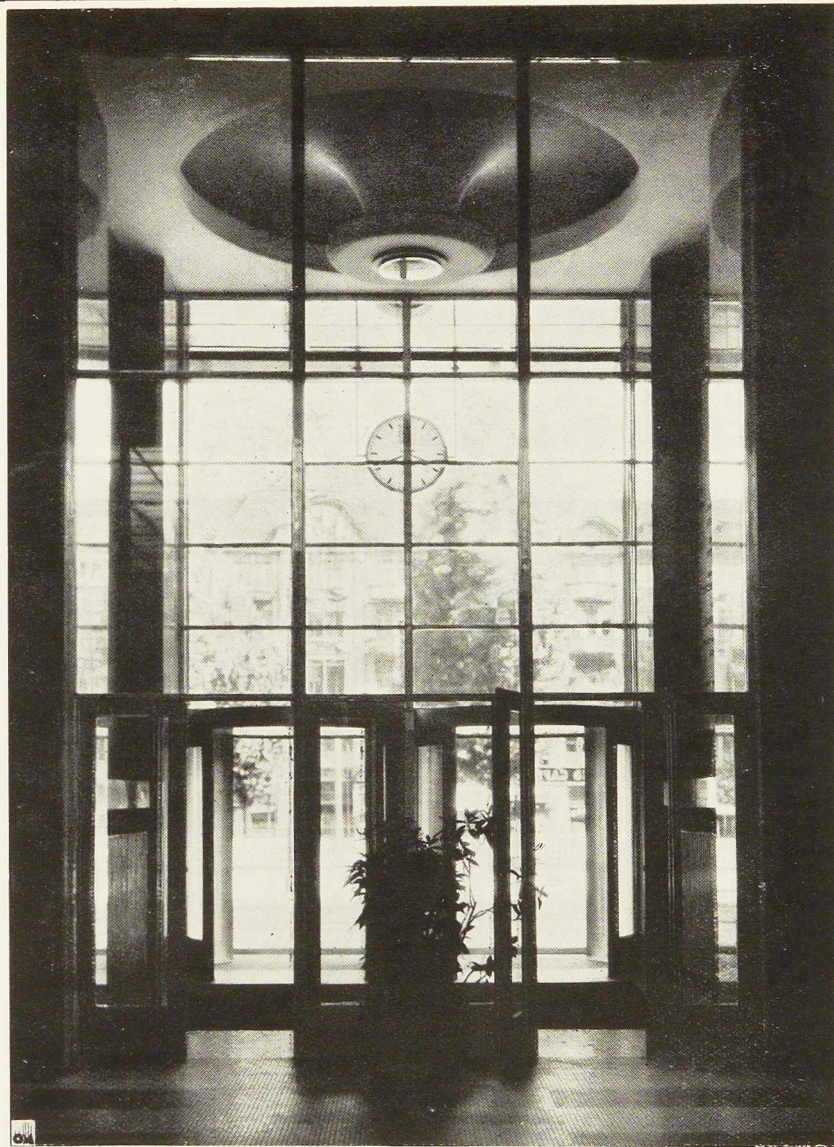
Fig. 195. Hall principal. Les châssis de fenêtres et les portes tournantes sont en acier.
