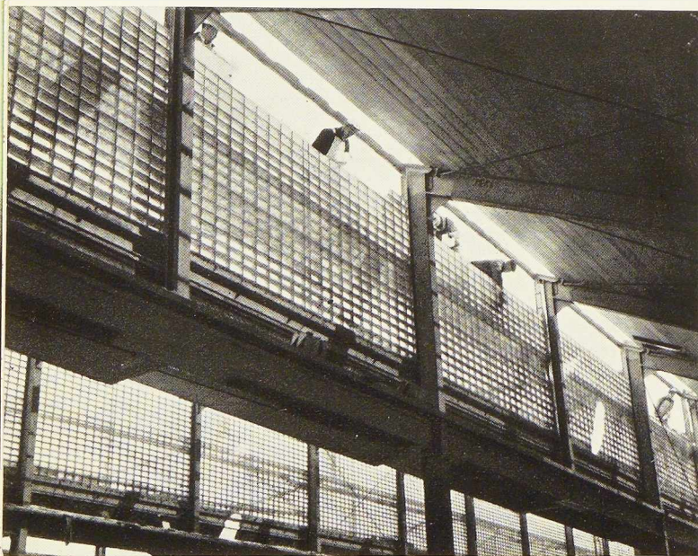
Fig. 166. Parois vitrées des sheds en construction. On note que les sheds ne comportent pas de tirants.
