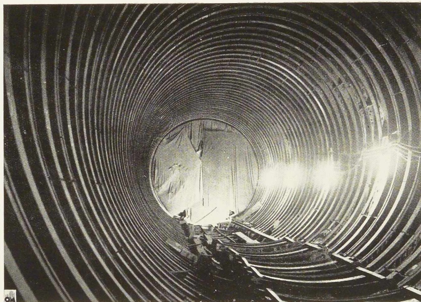
Fig. 217. Revêtement en acier laminé utilisé pour certains tronçons du tunnel. On se fera une idée de la dimension de ce tube en comparant cette photographie à celle de la figure 212.
