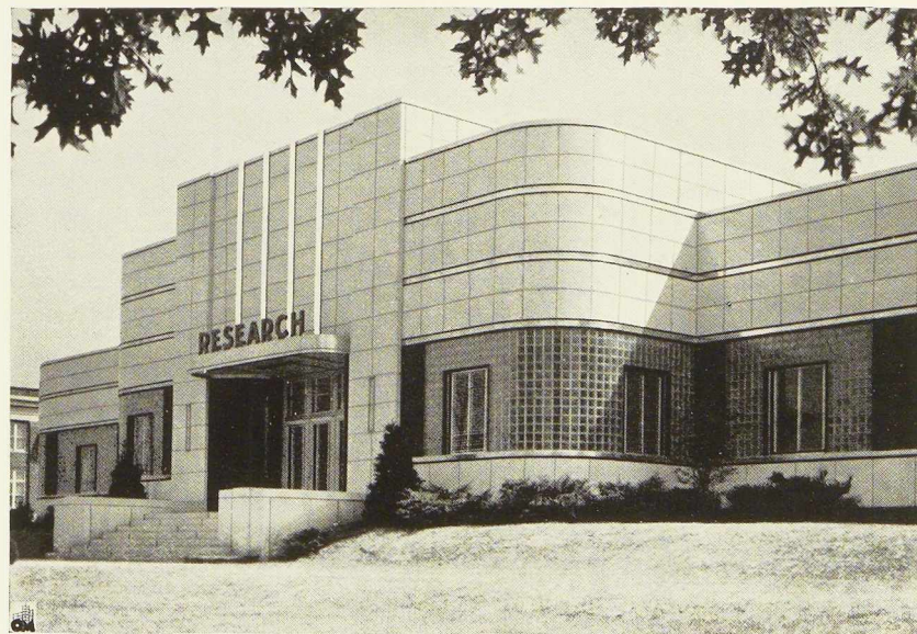
Fig. 159. Vue de la façade principale du bâtiment de recherches à Middletown.
