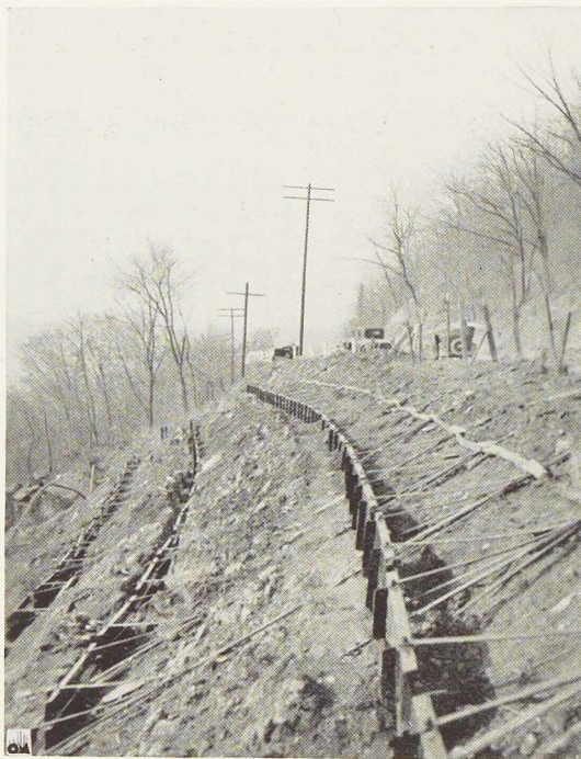
Fig. 51. Les plaques de soutènement sont placées sur 3 étages et maintenues en place par des tirants. Elles sont prêtes à recevoir la couche de remblai de couverture.
