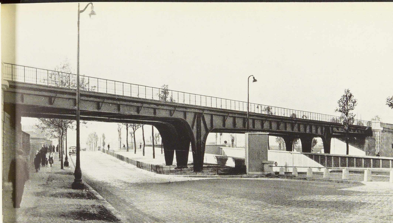
Fig. 37. Vue générale du pont-rails franchissant le boulevard Ney.
