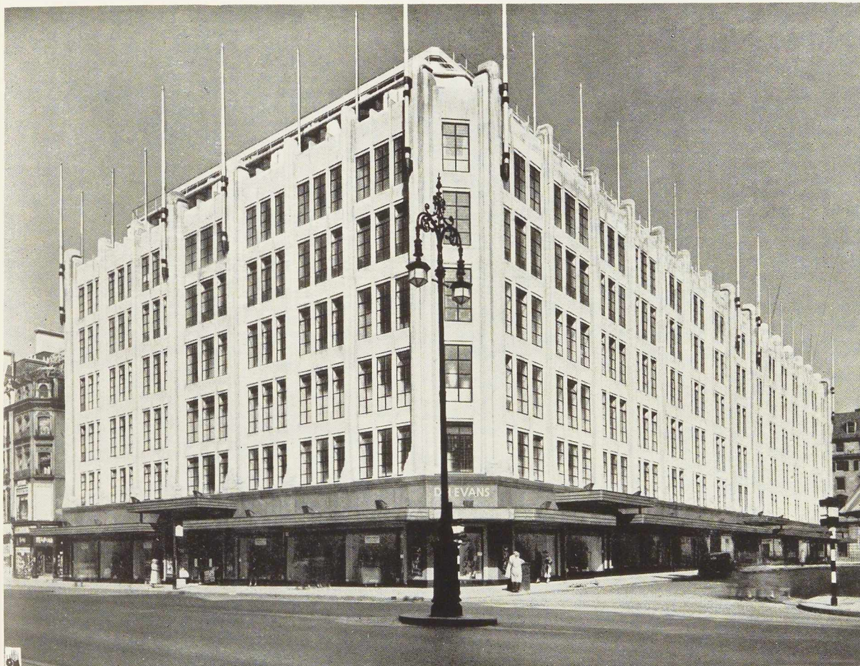
Fig. 23. Façade principale sur Oxford Street et Old Cavendish Street.
