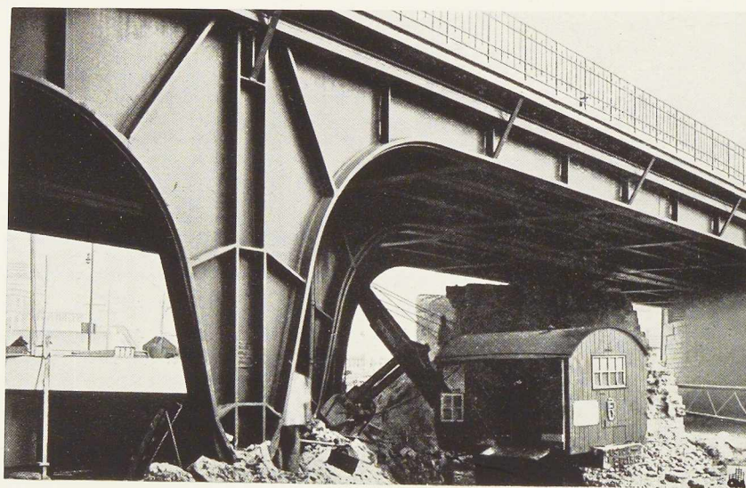
Fig. 44. Vue prise en cours des travaux, montrant le détail d'une béquille.
