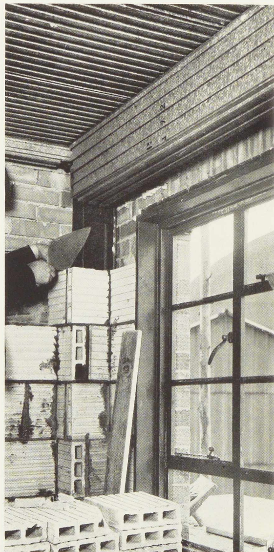
Fig. 9. Construction d'une cloison intérieure en briques creuses. On note que le châssis dormant de la fenêtre est déjà placé et que la cloison vient s'y adapter. La poutre du 1 er étage est entourée d'une tôle pliée en queue d'aronde sur laquelle sera appliqué directement l'enduit.
