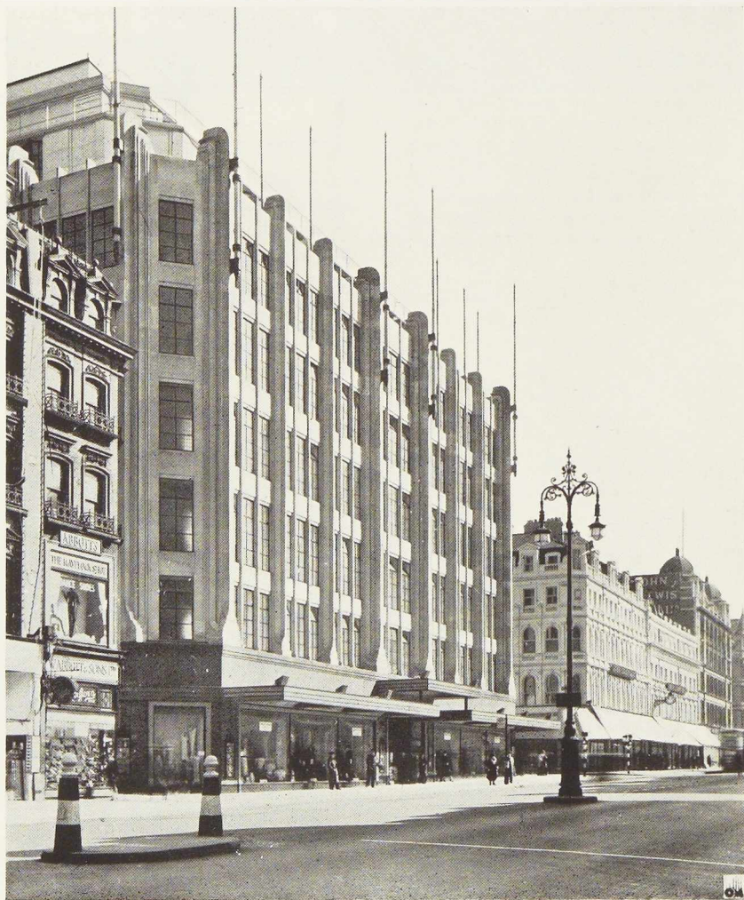
Fig. 33. Façade sur Oxford Street.
