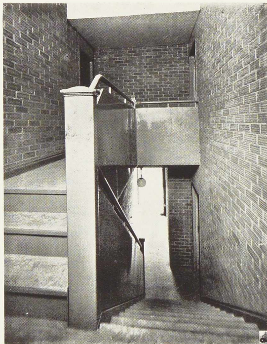
Fig. 4. L'escalier achevé. Les garde-corps sont en tôle peinte, les marches sont revêtues de granito.
