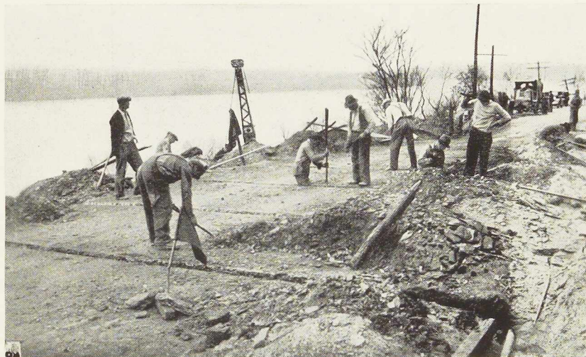
Fig. 48. Mise en place des barres d'ancrage.
