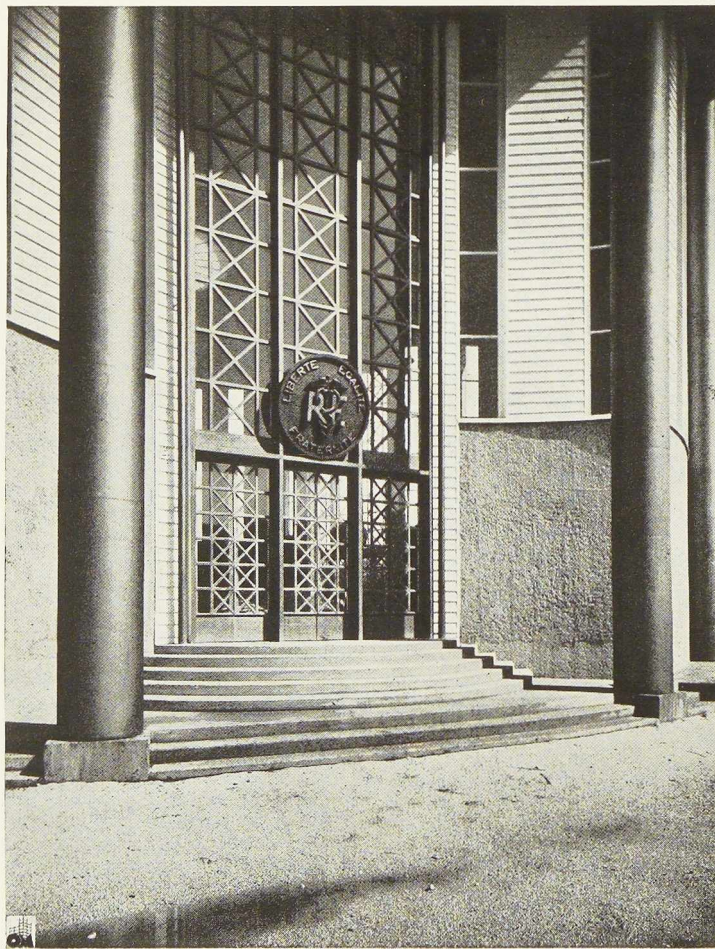
Fig. 759. Détail de la porte d'entrée du pavillon.
