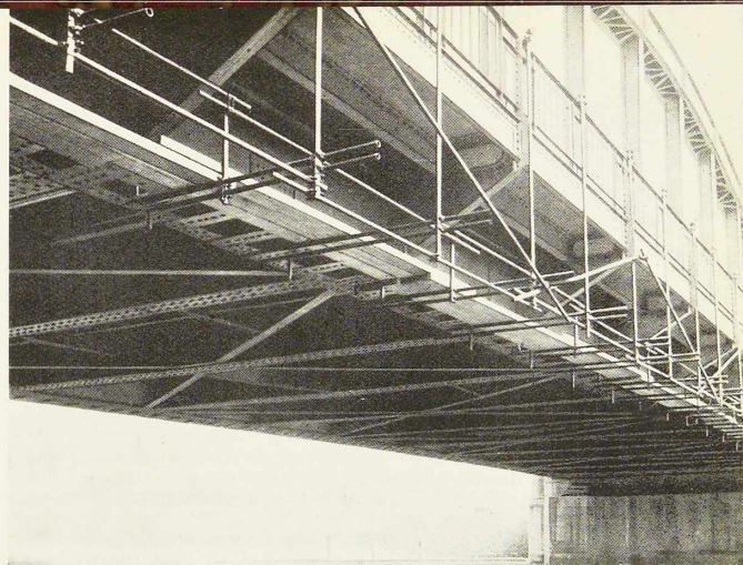
Fig. 672. Passerelle suspendue en tubes d'acier au pont Marexhe.
