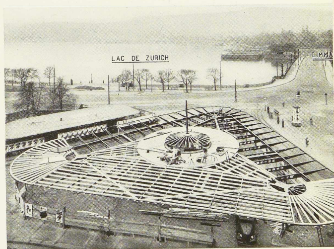
Fig. 614 (ci-contre). La charpente de l'avent en construction, vue prise le 12 novembre 1937.
