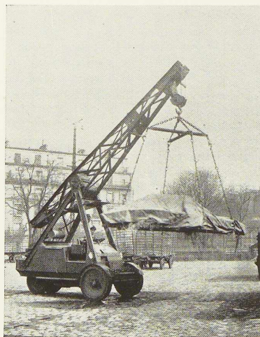
Fig. 630. Grue de faible encombrement utilisée par les chemins de fer français. (Clichés Le Container.)
