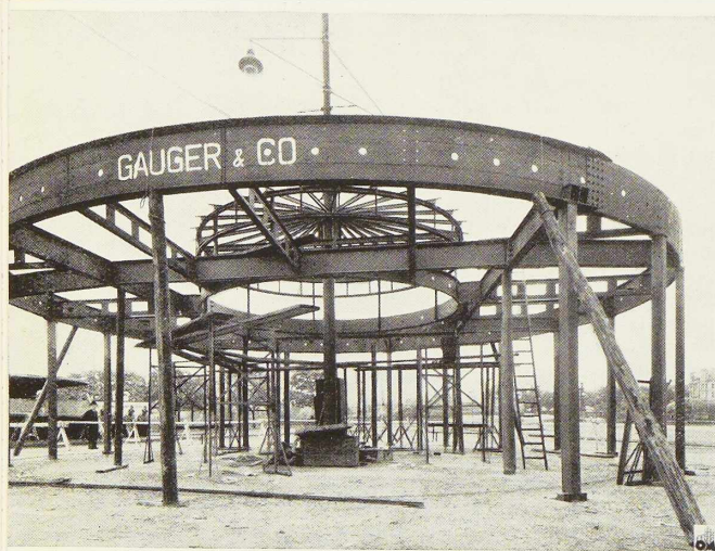
Fig. 612. Vue de l'ossature métallique du pavillon circulaire, prise le 4 octobre 1937.
