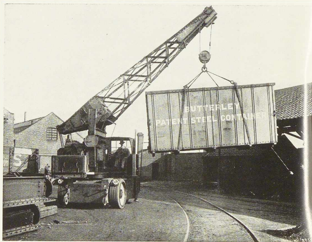
Fig. 629. Grue de 6 tonnes à flèche rotative employée pour la manutention des containers en Grande-Bretagne.
