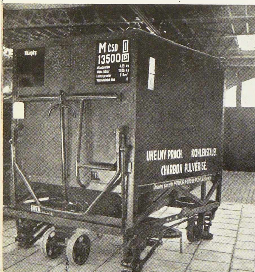
Fig. 622. Container pour transport de charbon pulvérisé.
