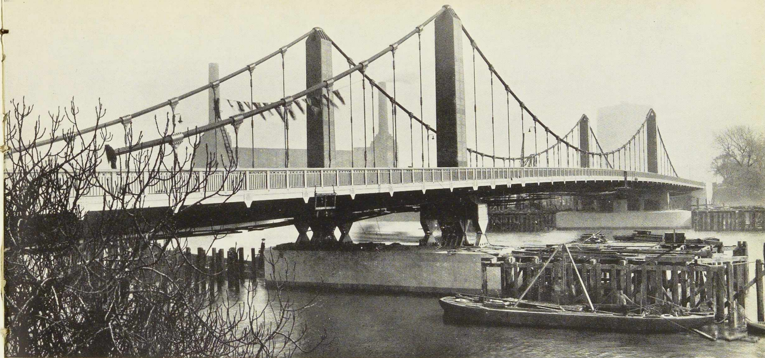
Fig. 584. Pont de Chelsea. Vue générale. On remarque l'absence de traverses à la partie supérieure des pylônes, qui sont entièrement isolés.
