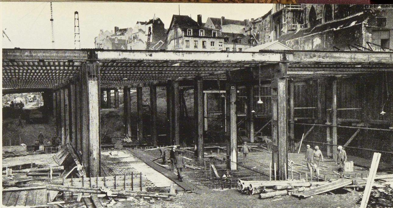
Fig. 434. Les premiers tronçons de l'ossature des trois pertuis accolés sont en place à la tête du tunnel côté midi; la fouille est creusée à l'intérieur de l'ossature qui constitue l'étaie des deux rideaux de palplanches. (Photo prise le 18 juin 1937.)
