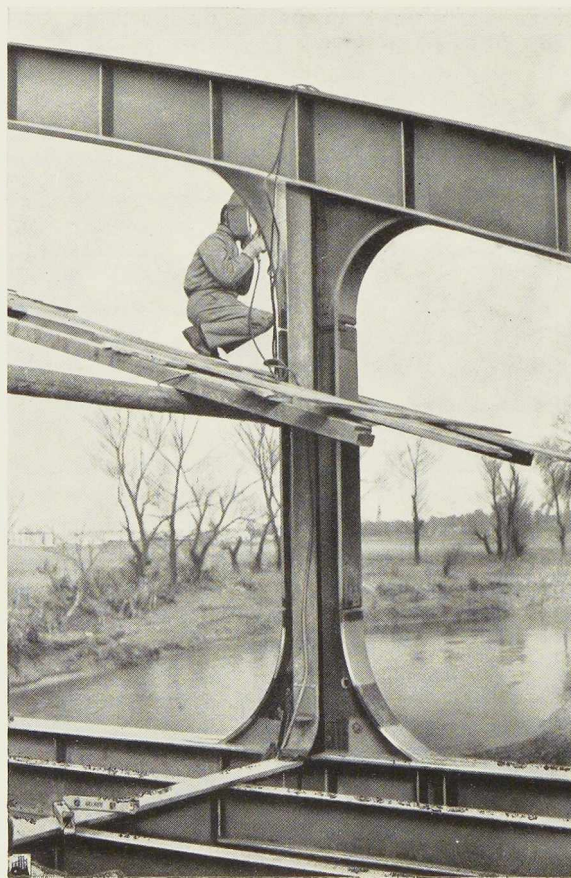
Fig. 409. Soudure d'un nœud de la membrure supérieure du pont.
