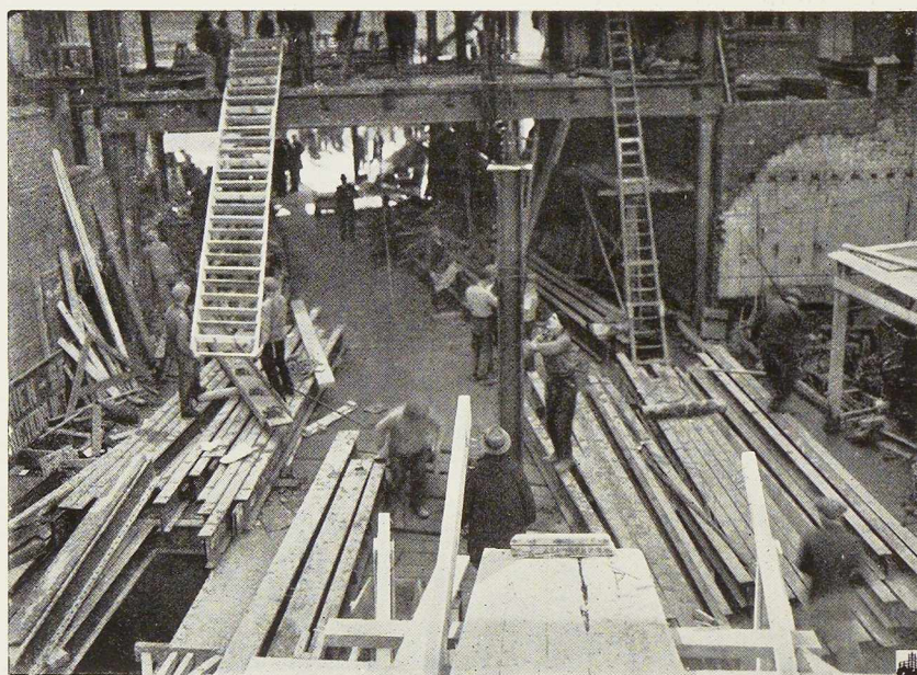
Fig. 356. Vue prise au cours des travaux. Noter le support des tôles de coffrage des hourdis, en forme d'échelle, que des ouvriers élèvent.
