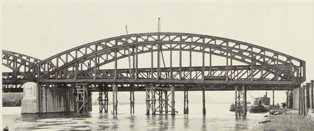
Fig. 384. Montage de la travée, rive droite, au-dessus de la Meuse.
