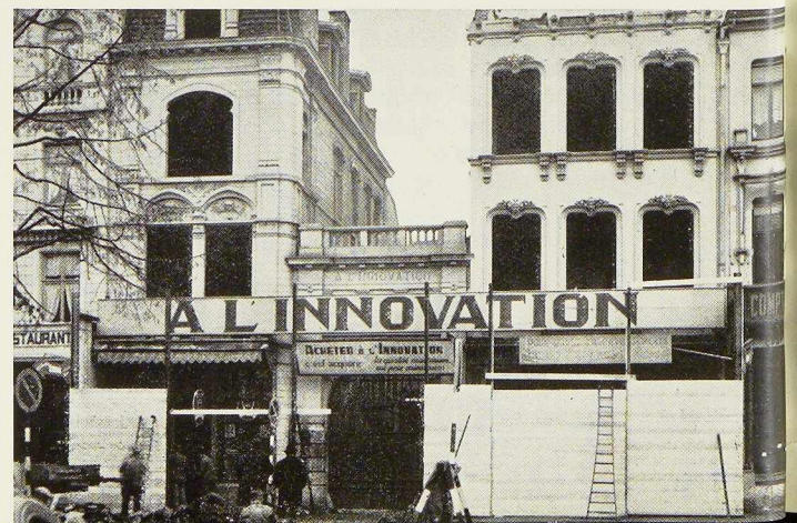
Fig. 352. Situation des lieux au début des travaux.
