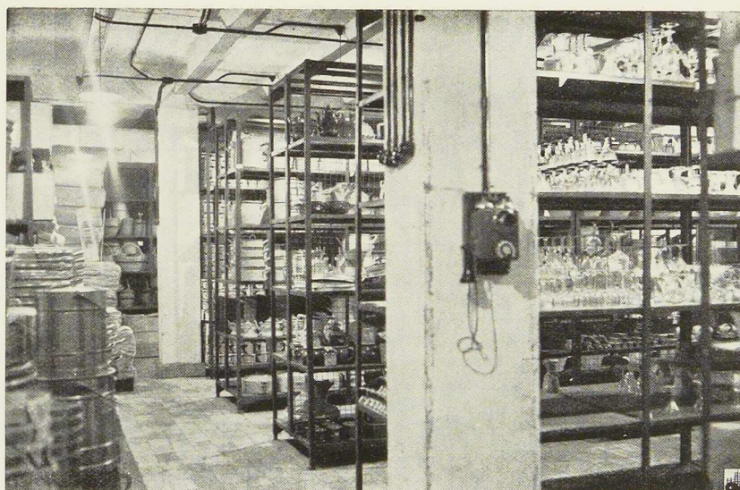
Fig. 357. Les rayonnages métalliques supportant les réserves au sous-sol.
