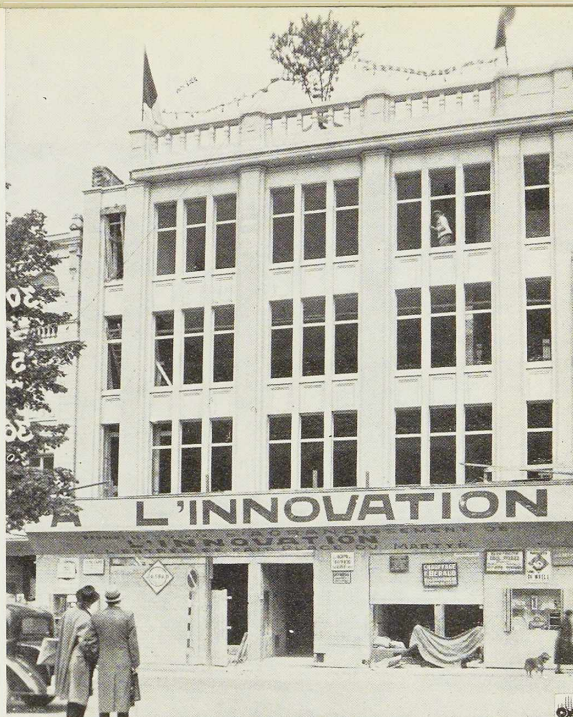
Fig. 354. La façade de la place Verte avant le commencement des travaux de démolition de l'hôtel du Régent (voir la situation définitive à la fig. 347).
