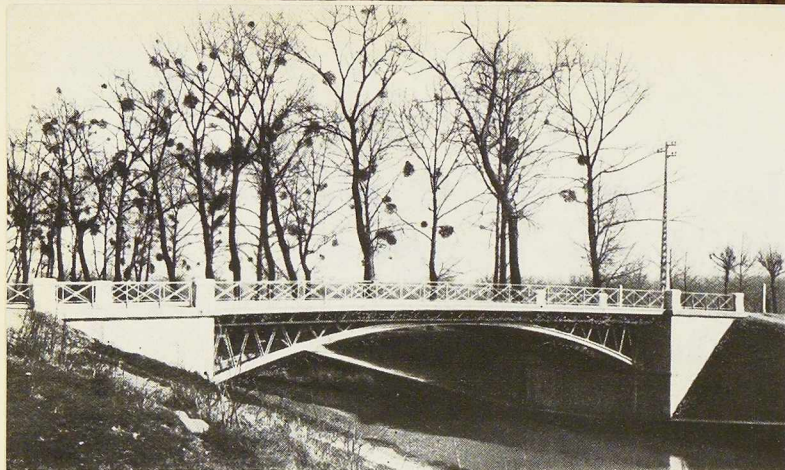
Fig. 311. Le pont de Vaires en France a été élargi en établissant deux nouveaux arcs entièrement soudés.
