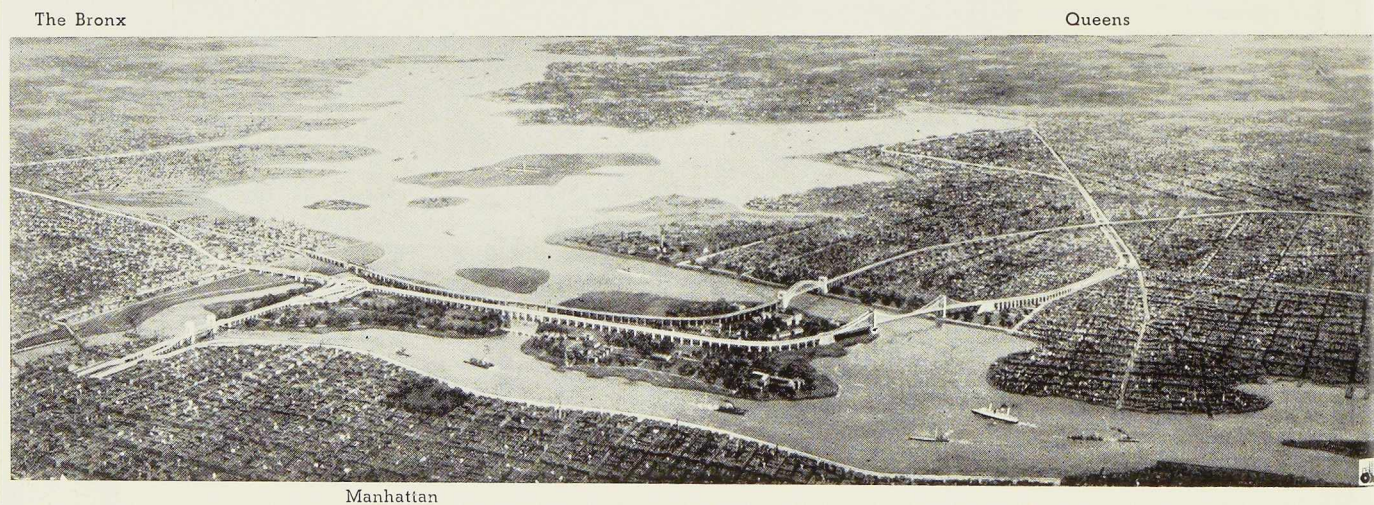
Fig. 206. Vue aérienne montrant le Triborough Bridge et les parties de New-York que cet ouvrage réunit.
