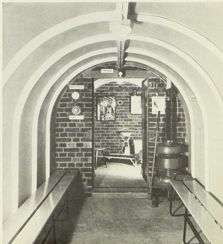
Fig. 246. Abri en tôles nervurées prenant appui sur une poutre faitière.
