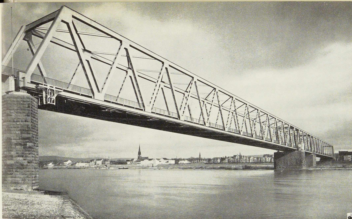
Fig. 220. Vue générale du pont franchissant le Rhin entre Neuwied et Weissenthurm.
