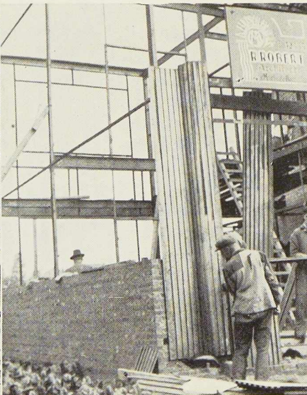
Fig. 166. Mise en place des tôles « Am'Acier ».
