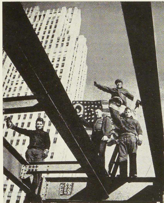
Fig. 202. On vient d'achever la construction d'un nouveau gratte-ciel de 36 étages et de près de 150 mètres de hauteur, il fait partie du groupe de gratte-ciel connus sous le nom de « Rockefeller Center », à New-York. Ce nouveau gratte-ciel a été construit dans un temps record. Son ossature métallique rivée comportant 9.000 tonnes a été entièrement montée en 43 jours ouvrables.
