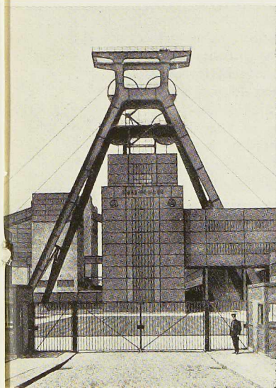
Fig. 170. Chevalement en arc à 2 rotules d'un charbonnage rhénan : bel exemple d'architecture industrielle.
