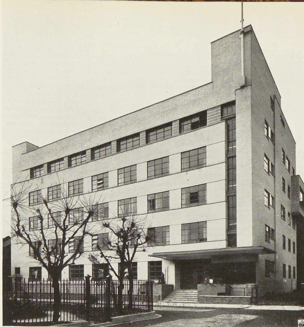
Fig. 173. Vue d'ensemble du nouveau bâtiment de l'hôpital allemand de Londres.
