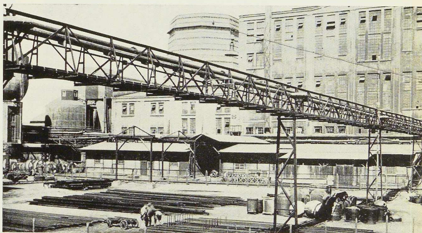
Fig. 51. Passerelles soudées pour conduites à Knapsack en Allemagne. Longueur totale : 80 mètres ; hauteur : 6 à 7 mètres ; charge par poutre : 280 à 335 kg par mètre. On a fait un usage exclusif de soudures bout à bout et d'angle.
