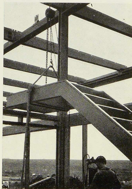
Fig. 32. Mise en place d'un escalier amené monté sur chantier.
