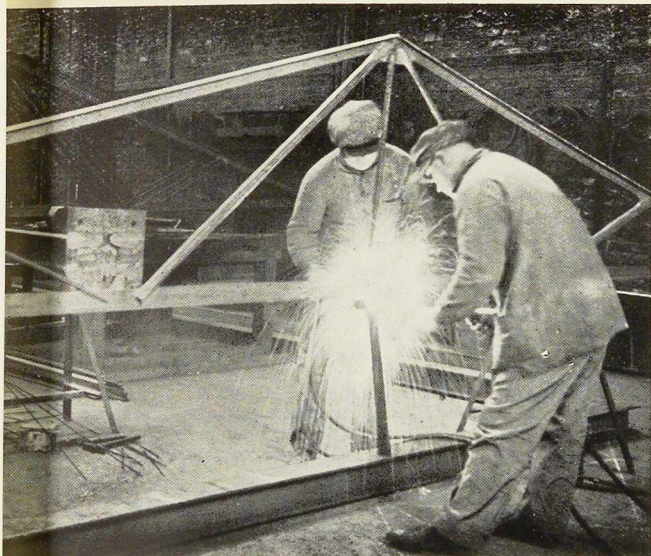
Fig. 57. Halle de 8 m 70 de portée, chaque ferme est constituée par deux demi-fermes triangulaires assemblées par soudure.
