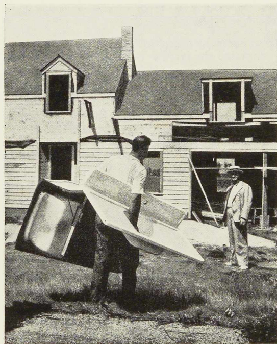
Fig. 71. Un seul homme porte une baignoire et un évier en tôle d'acier.
