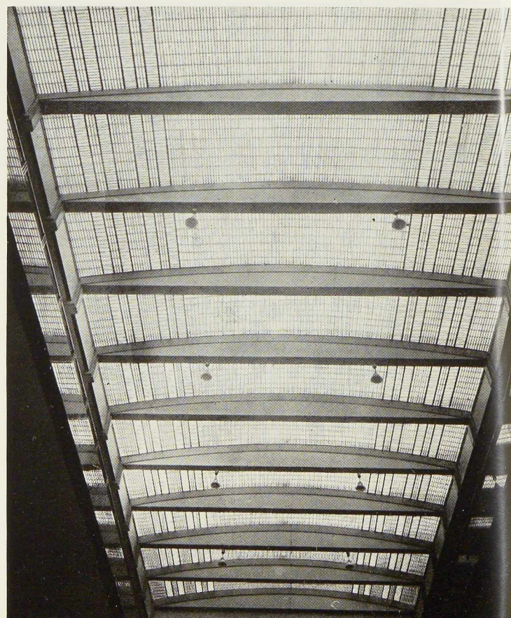
Fig. 793. La grande coupole en béton translucide.
