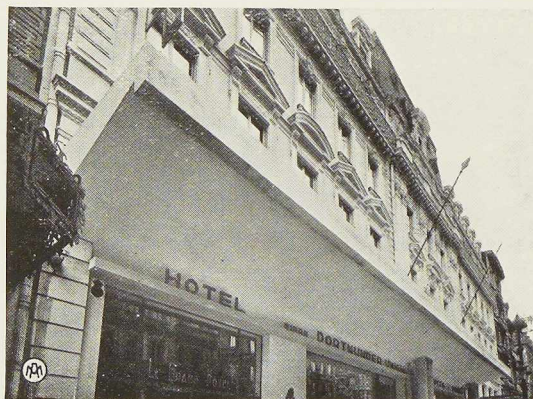
MARQUISE DU GRAND HOTEL, BRUXELLES INGÉNIEUR, ENTREPRENEUR : P. MEGANCK À ALOST
