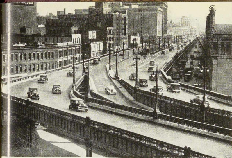
Fig. 810. La chaussée surélevée le long de l'Hudson à New-York. Virage et accès à hauteur de la 23 e Rue.
