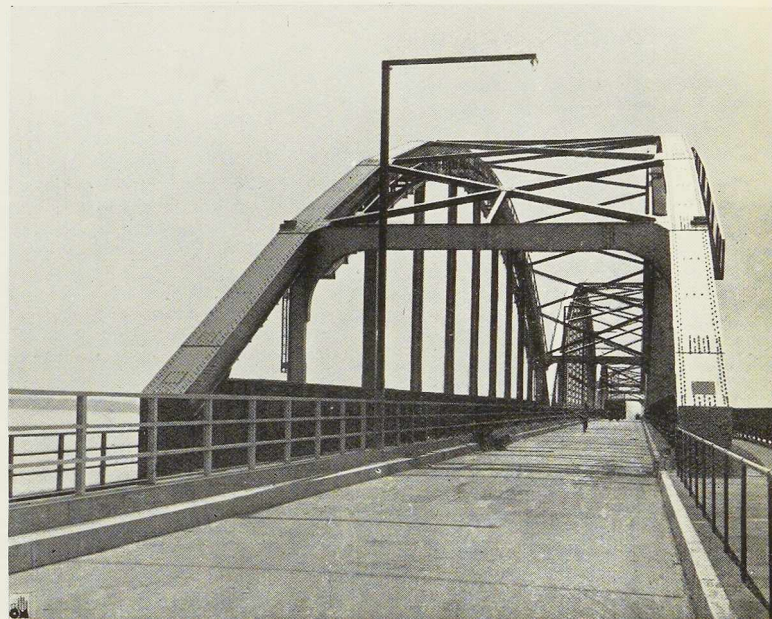
Fig. 772. Vue d'une travée en arc montrant notamment le contreventement supérieur.
