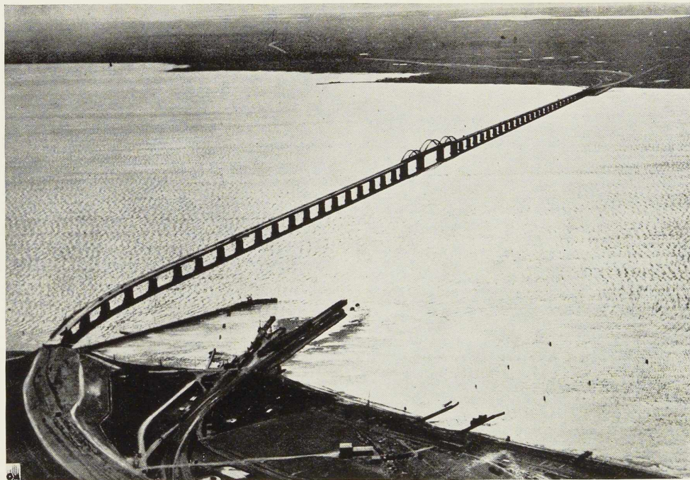
Fig. 759. Vue aérienne du pont sur le Storstrøm. A l'arrière-plan, on voit l'île Falster, à l'avant-plan, l'ancien port du ferry-boat et le port provisoire de montage.
