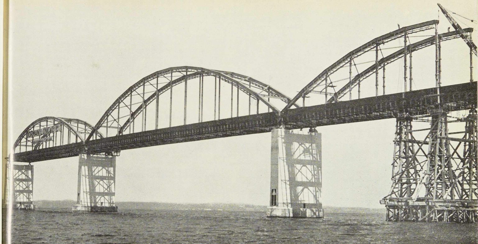
Fig. 769. Vue des trois travées centrales en arc de 102 m 30, 136 m 37 et 102 m 30 de portée.
