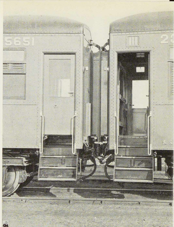
Fig. 740. Détail d'about de deux voitures. On note les diaphragmes métalliques assurant la communication entre voitures ainsi que les attelages automatiques.
