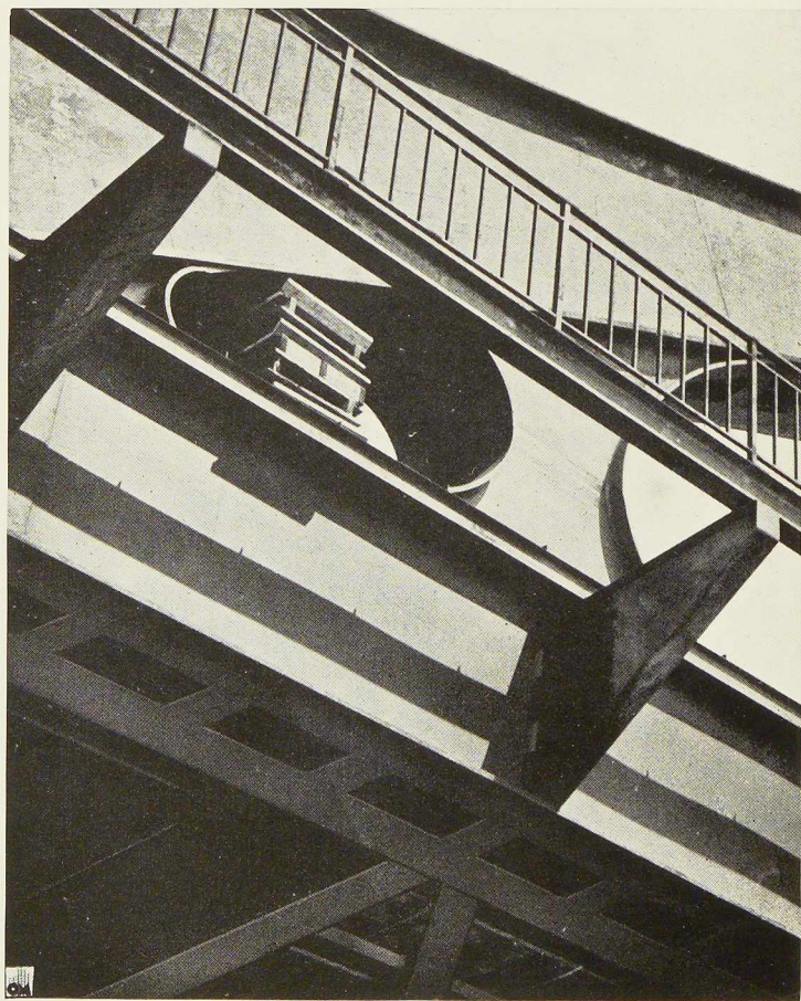
Fig. 703. Vue prise en cours de montage. On note la constitution en caisson des poutres principales. A la partie supérieure des montants, on voit deux plates-formes volantes pour soudeurs.
