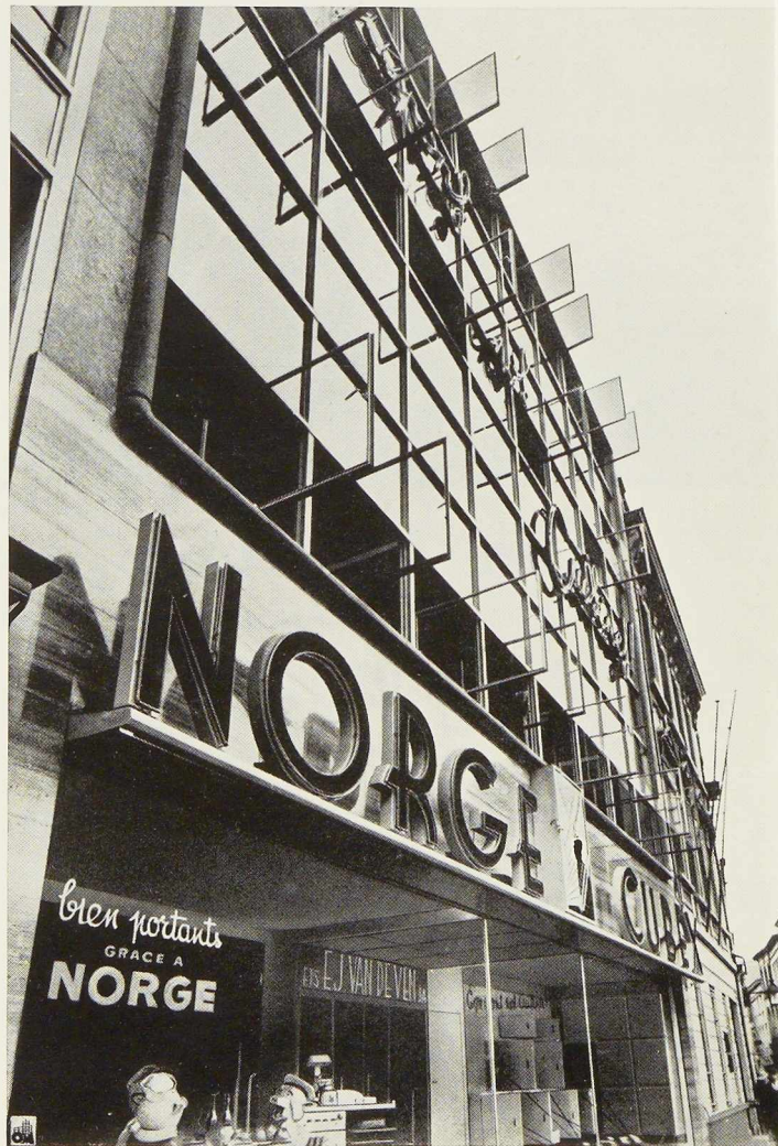
Fig. 723. Vue latérale de la façade vitrée dont les châssis mobiles sont ouverts.
