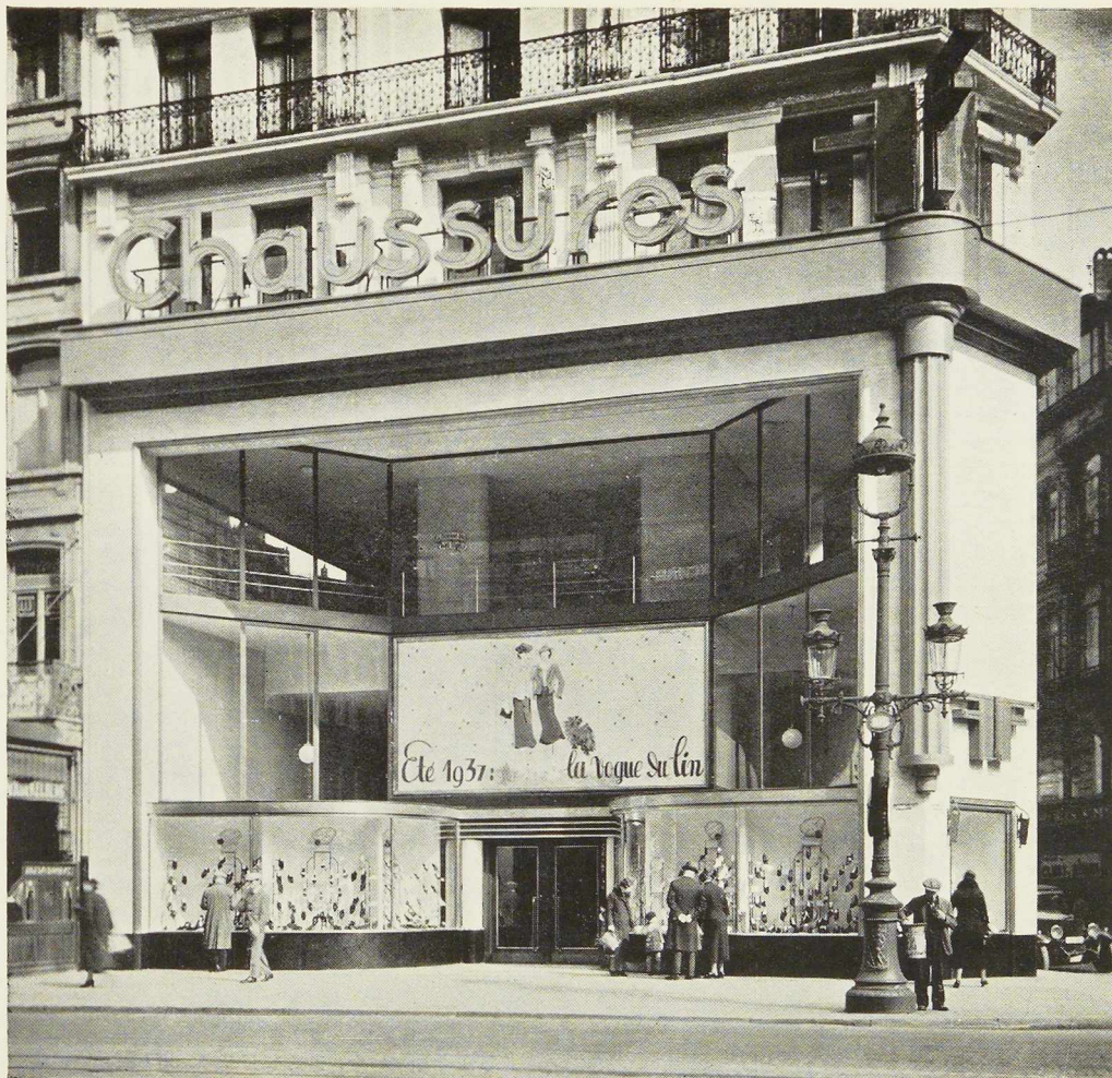
Fig. 710. Façade principale du magasin F.F. après transformation.
