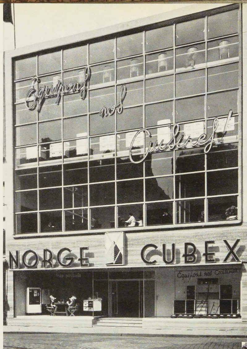
Fig. 721. Façade principale de l'immeuble transformé.
