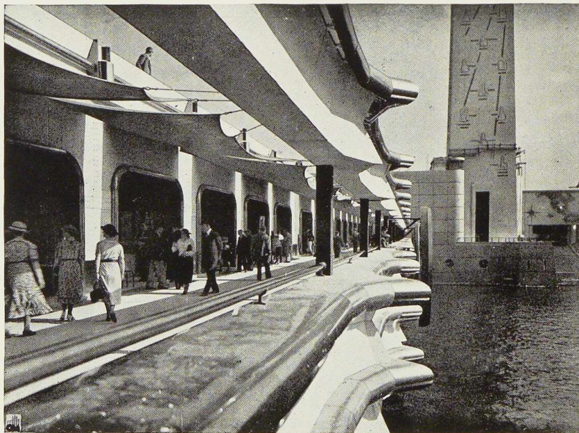
Fig. 641. La passerelle inférieure et les boutiques installées à l'intérieur des panneaux des poutres Vierendeel.
