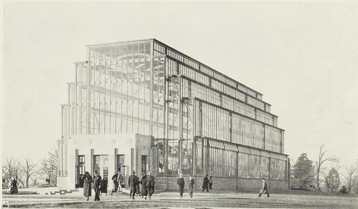
Fig. 666. Vue d'ensemble de la serre de Saint-Louis, E.-U.
