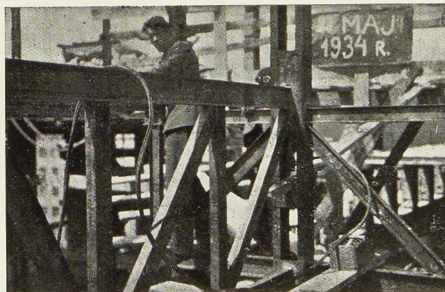
Fig. 558. Vue des poutres en treillis léger.
