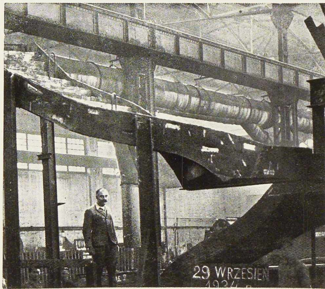
Fig. 562. Montage de l'escalier à l'atelier. On aperçoit bien le limon extérieur.
