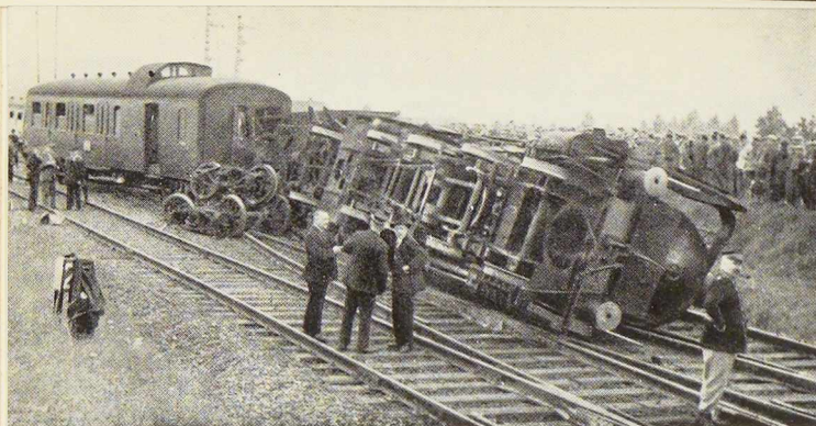
Fig. 569. Le déraillement de Lichtervelde. On note le parfait état des voitures métalliques.
