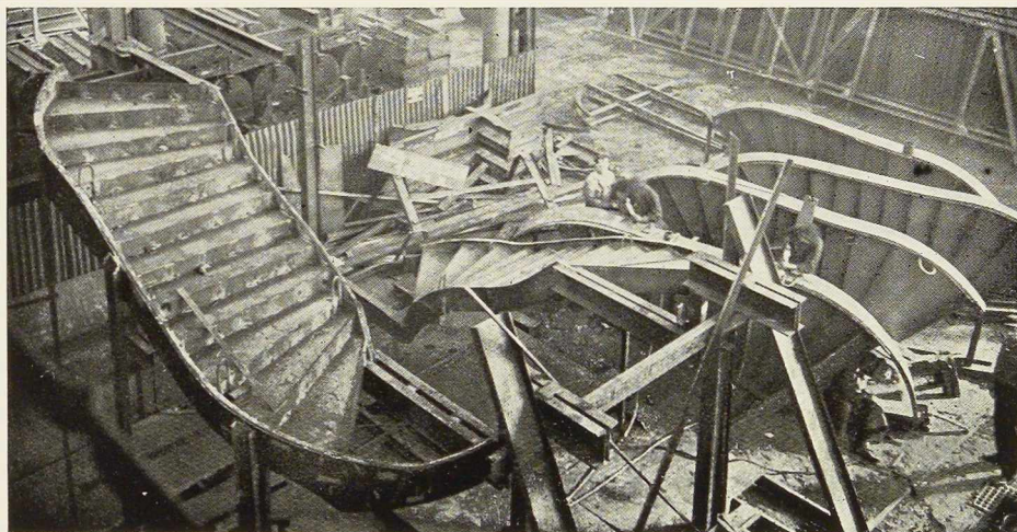
Fig. 564. Escalier pendant son montage à l'atelier.
