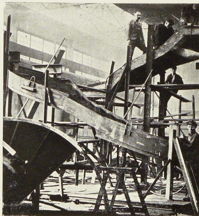
Fig. 563. Montage de l'escalier à l'atelier. Vue montrant l'exécution délicate de cet escalier.
