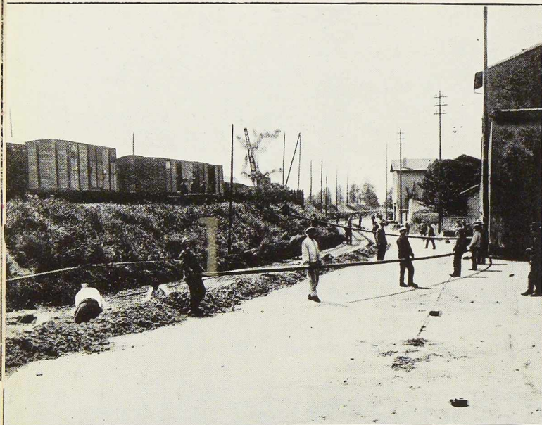
Fig. 480. Transport à pied d'œuvre de 150 mètres de tubes de 60 mm de diamètre assemblés par soudure. Cette photographie montre la grande souplesse du tube en acier.
