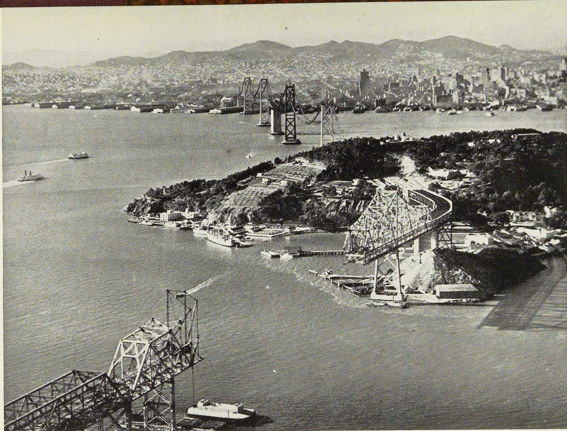
Fig. 355. Au premier plan, le pont cantilever du tronçon Est du pont de la baie ; derrière l'île Yerba Buena, et la reliant déjà à San-Francisco dont on aperçoit les gratte-ciel, on voit les travées suspendues du tronçon Ouest
