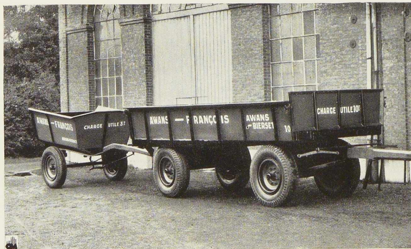
Fig. 408. Type de chariot tout acier de 10 T. remorquant un tombeau de 3 T., construits en Belgique.
