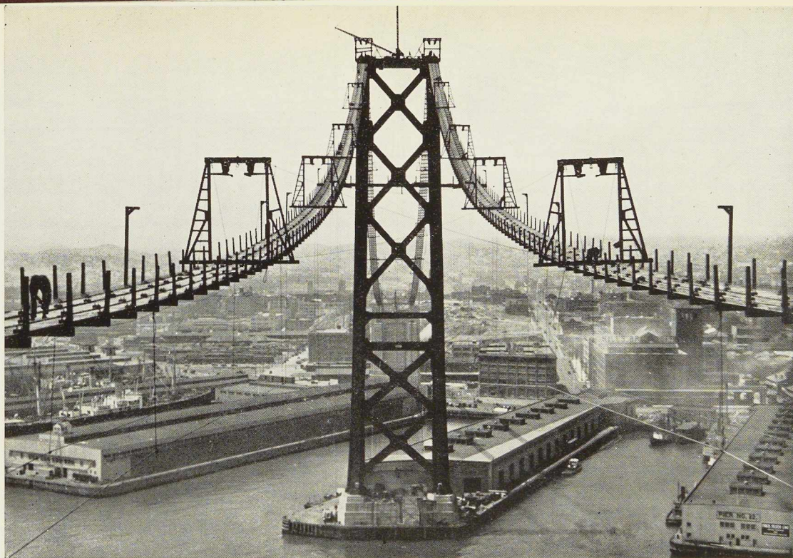
Fig. 363. Vue montrant un pylône, avec les passerelles de travail et les portiques servant de support au câble tracteur pour le filage des câbles.
