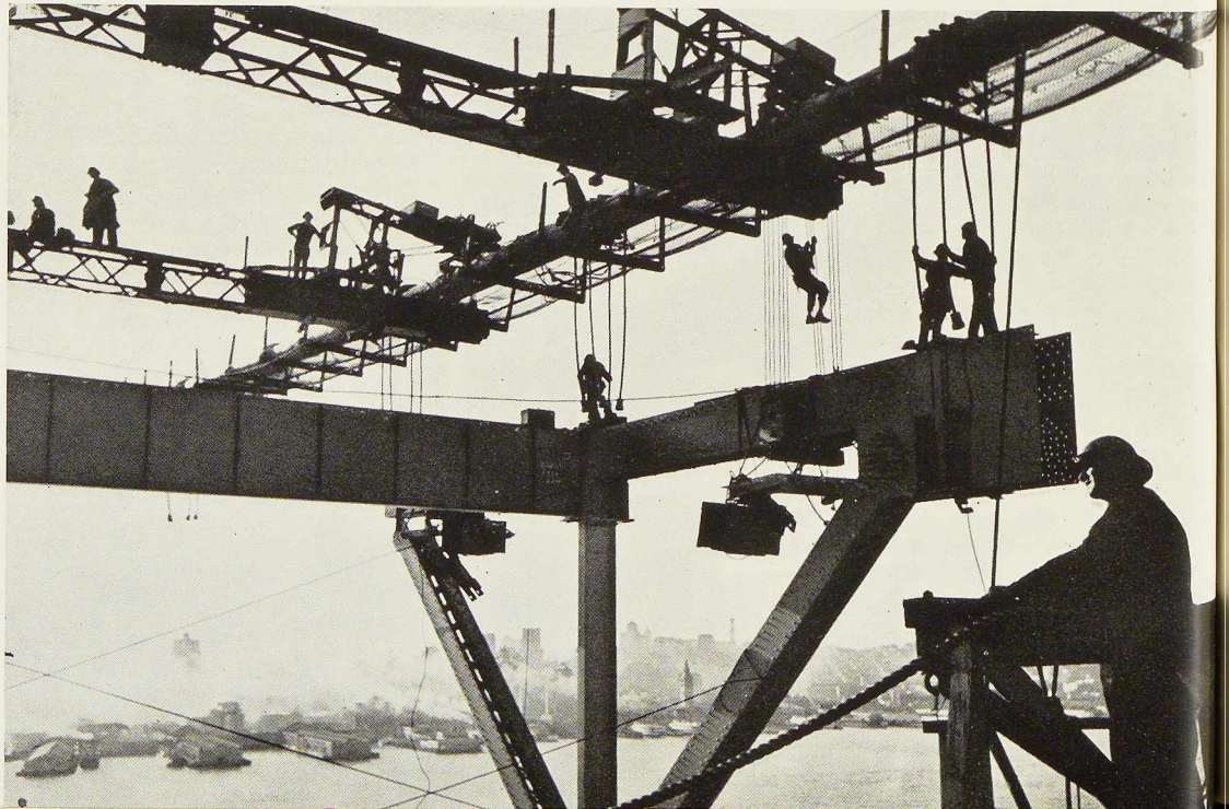
Fig. 369. Même section à 1 m 83 de sa position définitive, avant sa fixation aux culots.
