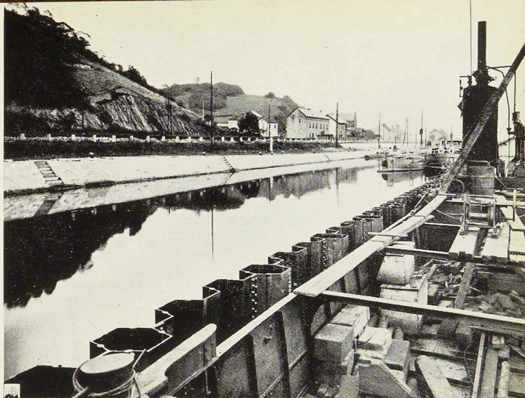
Fig. 336. Utilisation de 90 tonnes de palplanches Ougrée n° IV de 7 mètres avec caissons rivés lors de la construction de l'estacade d'Ampsin-sous-Huy. Entrepreneur : M. De Graeve.
