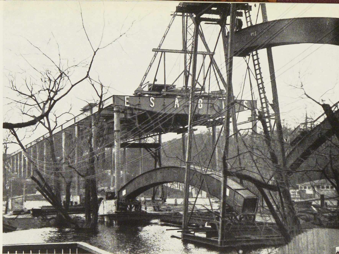
Fig. 257. Montage d'un des arcs du Pont du Pâlsund.
