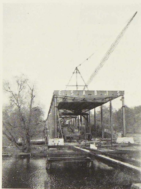
Fig. 249. Le viaduc d'accès reliant le Västerbron et le Pont du Pålund.
