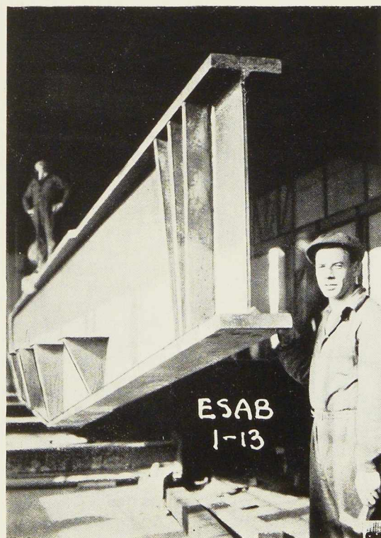
Fig. 255. Poutre transversale du Pont du Pâlsund.
