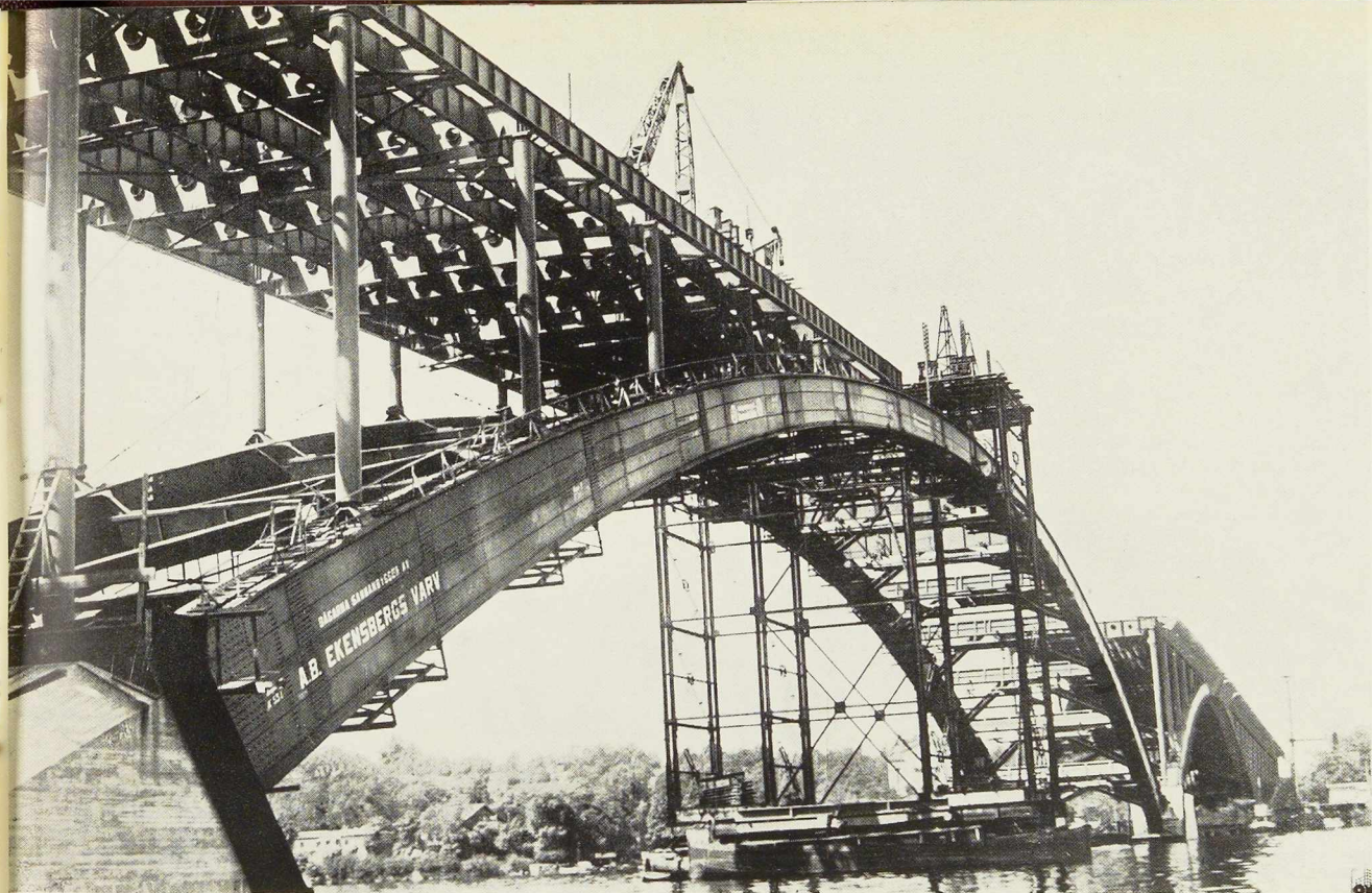
Fig. 251. Montage des arcs du Västerbron. Ceux-ci sont amenés sur place par demi-arcs et sont assemblés grâce à une tour de montage.
