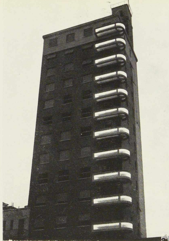
Fig. 237. Vue montrant les balcons en béton translucide éclairés intérieurement.
