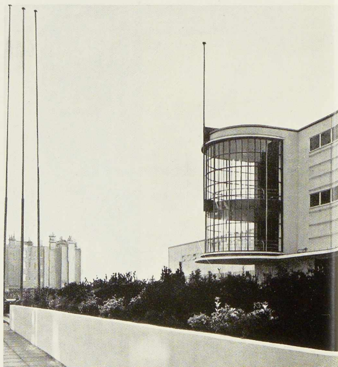
Fig. 172. L'escalier nord est entièrement en porte-à-faux ; il est muni d'un vitrage sur toute sa hauteur. (Cliché « Building ».)
