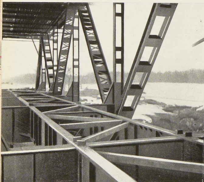
Fig. 84. Vue générale du pont soudé au-dessus de la Dema, sur le chemin de fer Ufa-Iszimbaevo.
