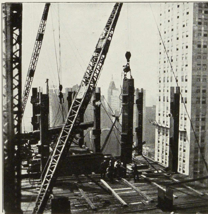
Fig. 6. Mise en place d'un poteau métallique, soulevé verticalement par une grue-derrick. Des broches sont placées dans de larges œilletons réservés dans les couvre-joints prolongés des ailes des colonnes.
