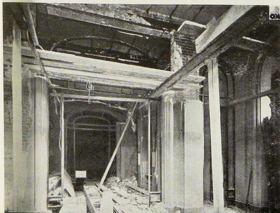
Fig. 22. Vue prise avant les travaux montrant l'importance des murs et la petitesse des portées libres.
