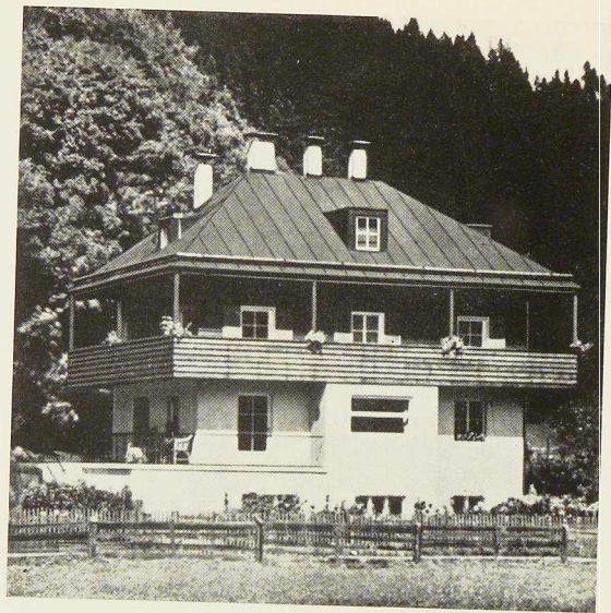
Fig. 663. Maison couverte avec de la tôle nervurée.
