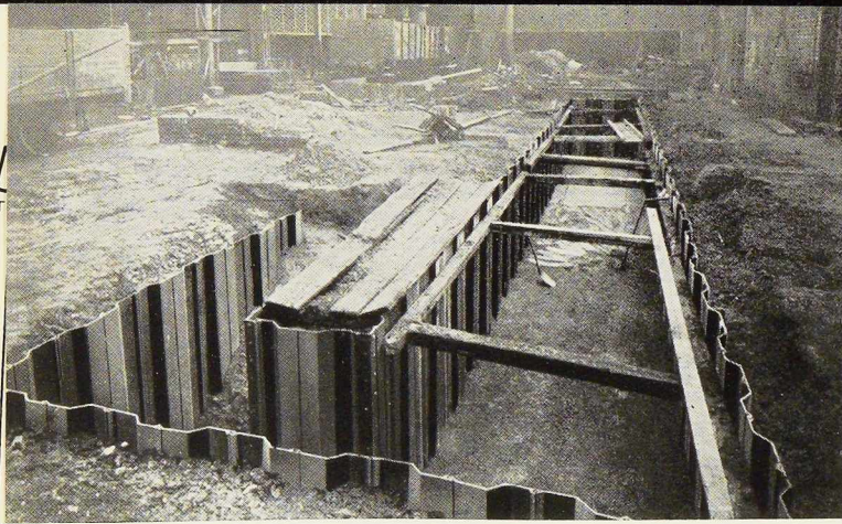
Fig. 637. Construction d'un abri en palplanches métalliques.
