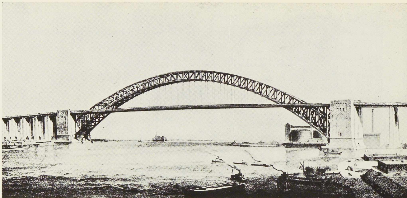
fig. 577. Le pont sur le Kill van Kull à New-York est le plus grand pont en arc du monde. Sa portée atteint en effet 503 m 90.
