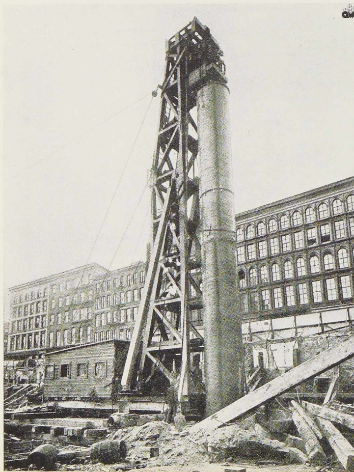
Fig. 495. Forage d'un des cylindres d'acier des fondations du nouveau Bâtiment Fédéral à New-York.
