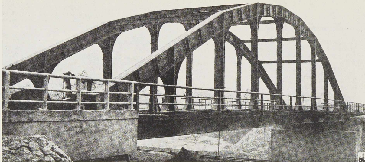
Fig. 500. Vue générale du pont de Nuth.
