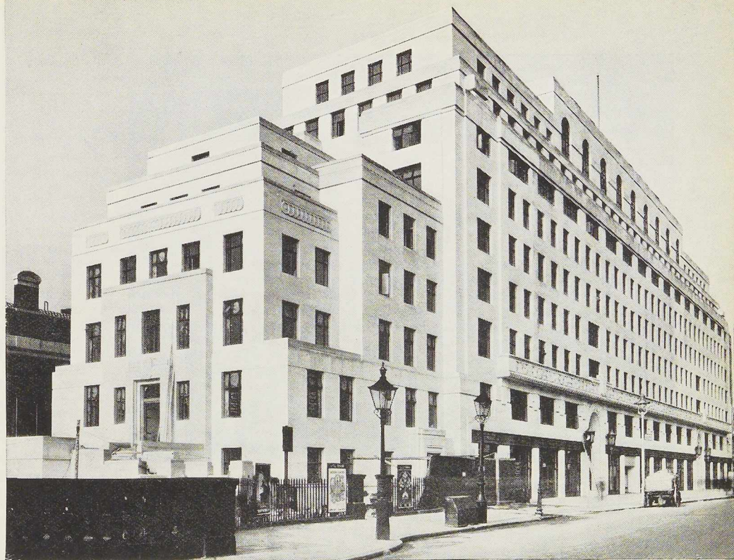
Fig. 492. La Brettenham House, à Londres, bâtiment pour bureaux construit en ossature métallique. Architectes: W. et E. Hunt, F.R.I.B.A.
