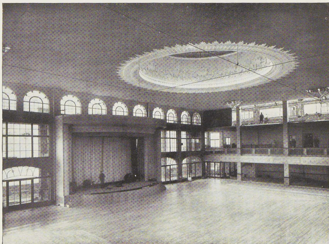
Fig. 494. La salle de danse du Royal Hall à Bridlington. La façade vers la mer est largement vitrée de façon à donner aux danseurs une belle vue sur la mer. Architecte : P. Maurice Newton, A. R. I. B. A.
