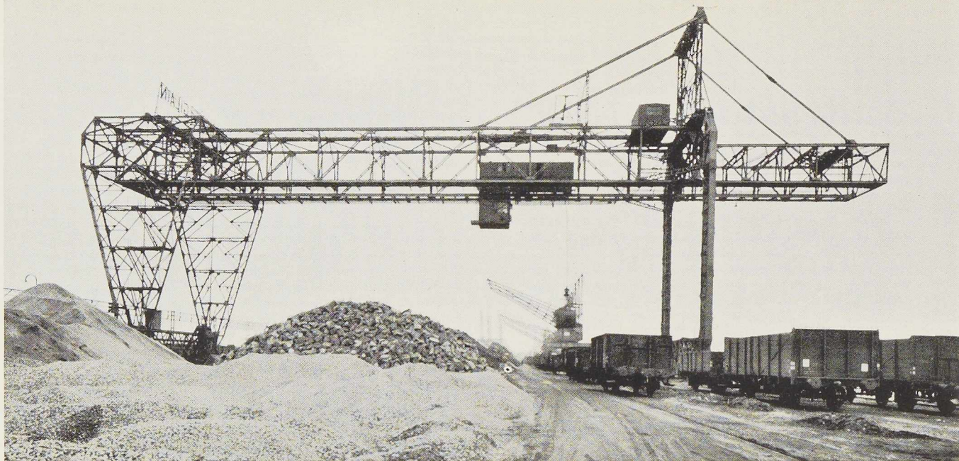
PONT-PORTIQUE AU PORT DE BRUXELLES, FOURNI À MM. CLAES ET C o , À BRUXELLES. Ce pont-portique, à grappin à bec relevable, est capable d'un débit industriel de 300 T/heure.
