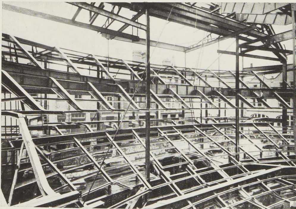
Fig. 444. Vue générale de la charpente du Théâtre d'Oxford. On aperçoit les étaçons provisoires servant au montage de la toiture.
