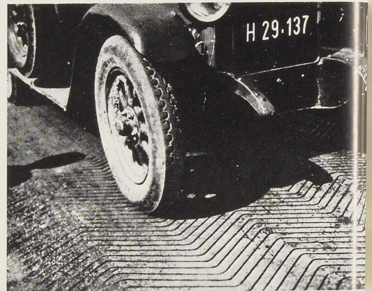
Fig. 452. Revêtement de route en grillage d'acier réalisé à Dusseldorf.
