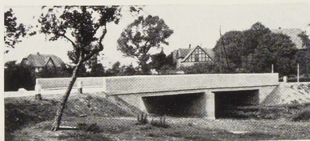
Fig. 277. Pont de Flechtdorf-Campen sur la Schunter, comportant deux travées de 8 mètres de portée chacune.
