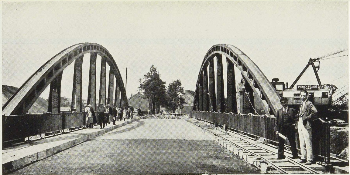
Fig. 253. Vue transversale du pont. On note l'absence totale du contreventement supérieur. (Cliché Technique des Travaux)
