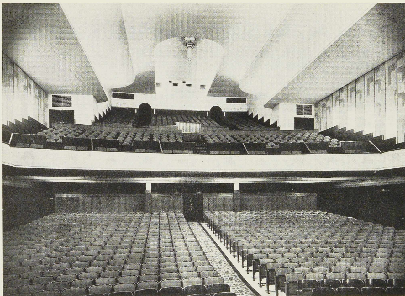
Fig. 199. La salle, vue vers l'arrière. Le balcon ne repose que sur deux poteaux intermédiaires que l'on aperçoit à la dernière rangée de fauteuils. A noter la disposition en gradins du platond et le mode d'éclairage de la salle.
