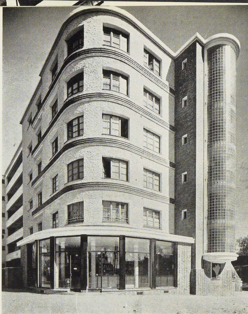
Fig. 214. Angle du grand bâtiment
