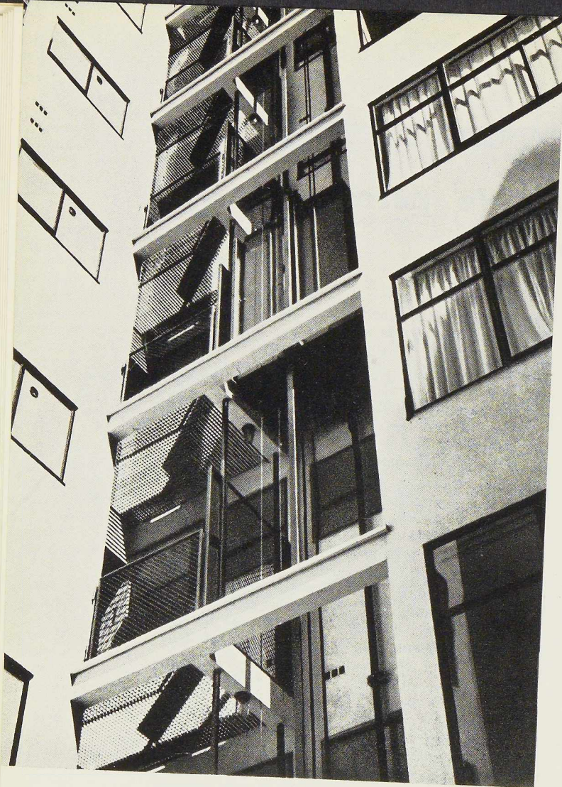
Fig. 204. Les portes et les paliers de l'ascenseur de service sont en caillebotis métallique à grandes mailles laissant passer la lumière.
