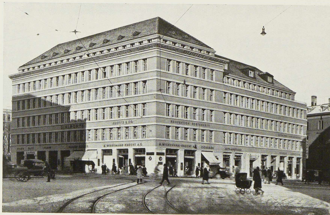
Fig. 103. Le bâtiment Sihlporte à Zurich. Surface bâtie : 2.000 mètres carrés. Poids de l'ossature métallique : 750 tonnes, soit 19,5 kg par mètre cube de bâtiment. Année de construction : 1926.
