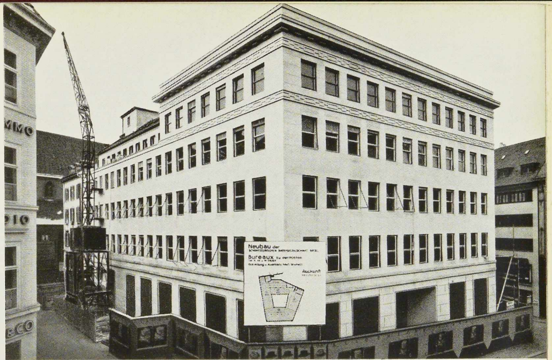
Fig. 104. Le bâtiment de la Société Suisse de Banque à Bâle. Surface bâtie : 950 mètres carrés. Poids de l'ossature métallique : 650 tonnes, soit 25,5 kg par mètre cube de bâtiment. Murs de façade en maçonneries avec revêtement en pierre de taille. Année de construction : 1931.
