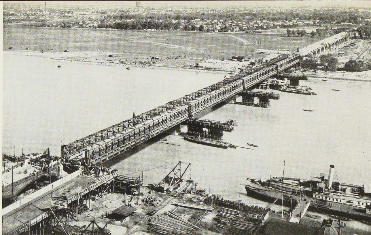
Fig. 121. Vue générale, prise le 12 septembre 1934, montrant le pont en cours de ripage.
