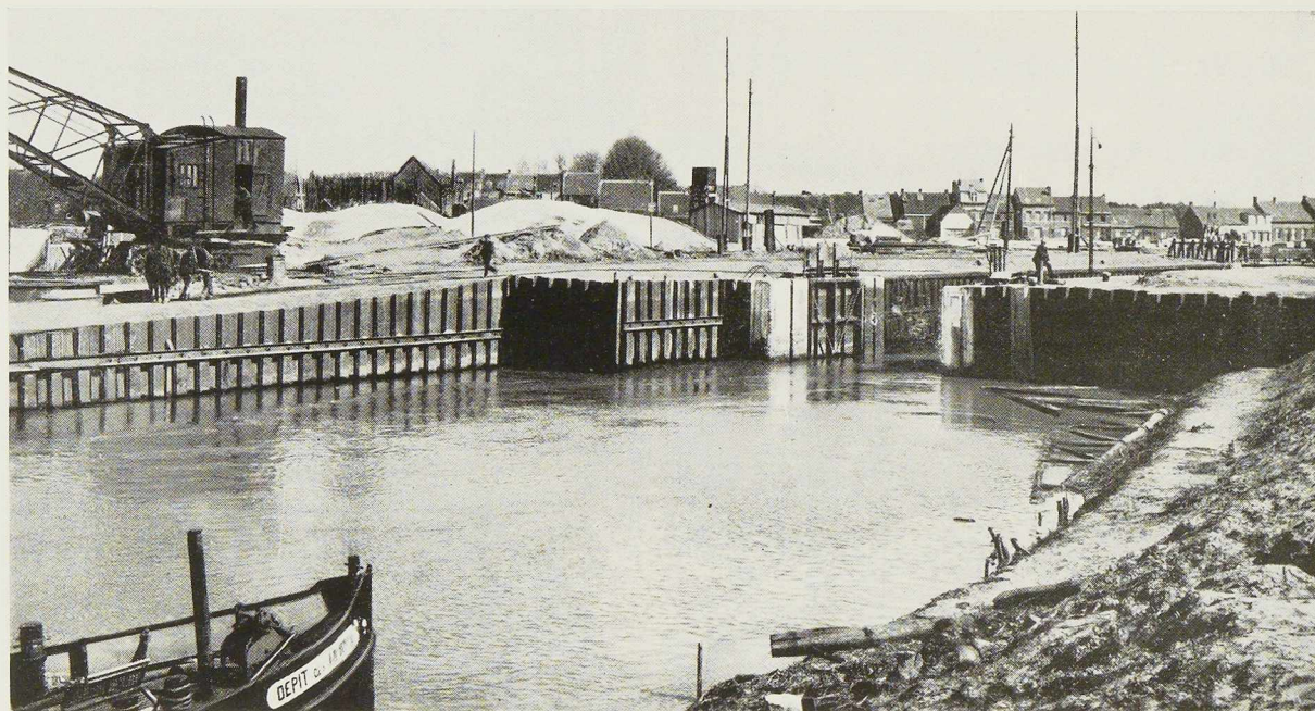
Fig. 93. Vue de la tête aval de l'écluse de Wynegem. On notera que les murs en retour et les murs de quai d'approche sont également en palplanches métalliques.
