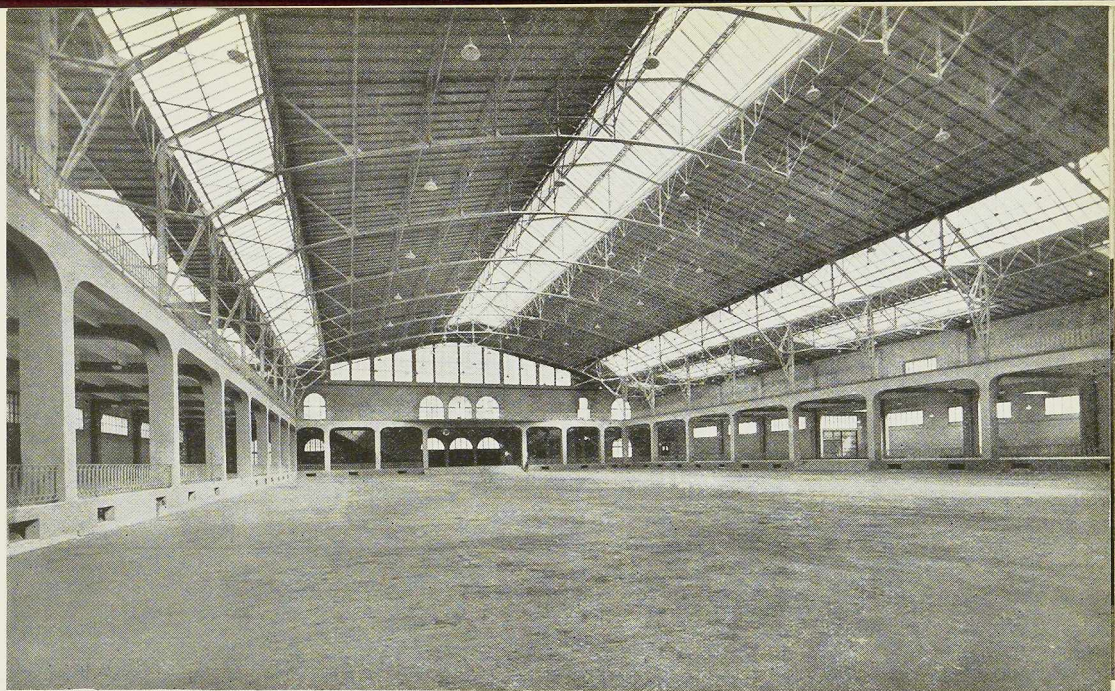
Fig. 100. Le Palais des Expositions à Genève. La toiture est supportée par une série d'arcs à 2 rotules en treillis, de 47 m 50 de portée, présentant de chaque côté un porte-à-faux de 12 m. Longueur de la halle : 106 m. Tonnage d'acier : 350 tonnes, soit 45 kg par mètre carré de surface couverte. Année de construction : 1926.
