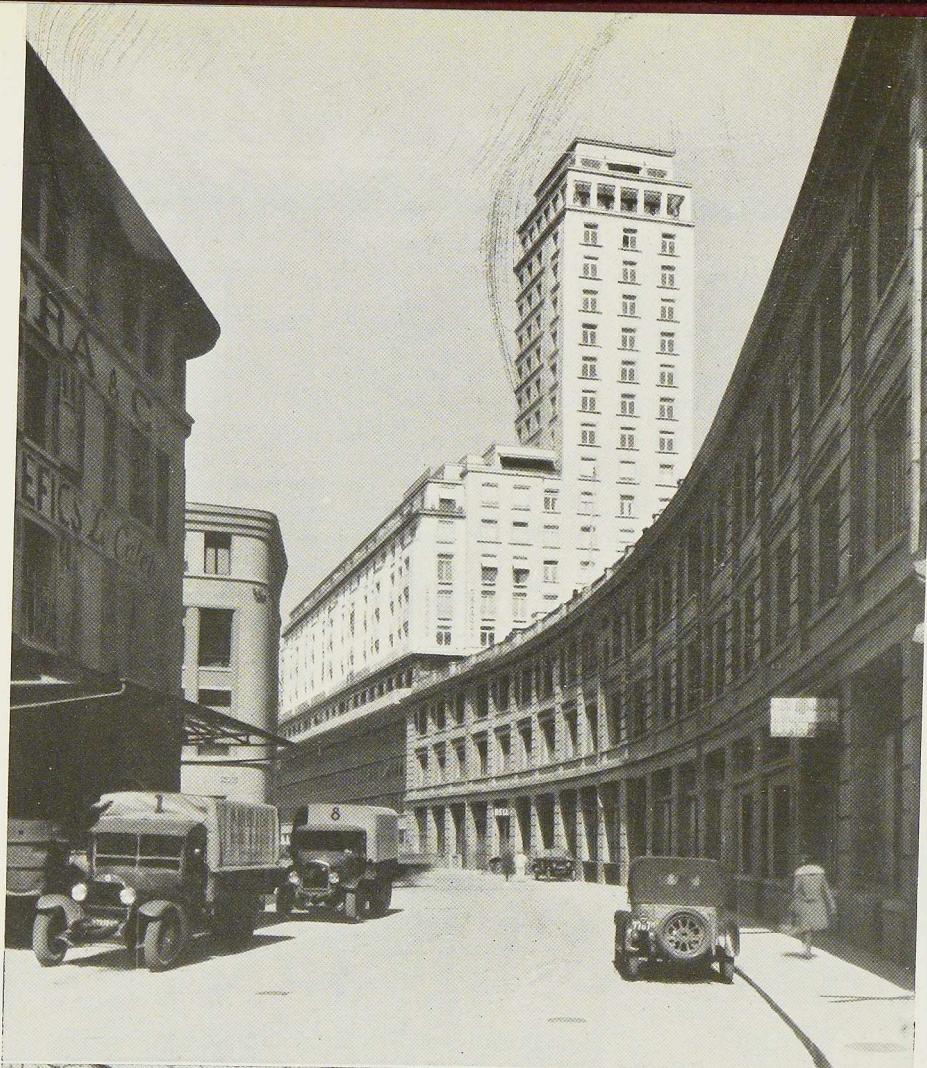
Fig. 119 et 120. Le bâtiment Bel-Air Métropole à Lausanne, le premier gratteciel de Suisse. Surface bâtie 3.800 mètres carrés, hauteur 66 m 70, volume bâti 120.000 mètres cubes. L'ossature métallique a été entièrement soudée, tant à l'atelier que sur le chantier. Tonnage d'acier 2.100 tonnes, soit 17,5 kg par mètre cube de bâtiment.
