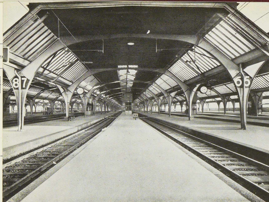
Fig. 99. Les halles de la gare de Zurich. Vue d'un arc à 3 rotules, à âme pleine. Les halles ont été construites en 1930-1931.
