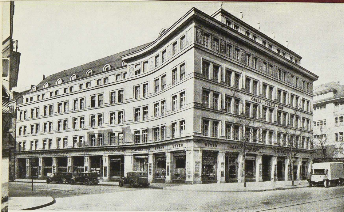
Fig. 102. Le bâtiment Orell Füssli-Hof à Zurich comporte une surface bâtie de 1.135 mètres carrés. L'ossature métallique pèse 450 tonnes, soit 18,6 kg par mètre cube de bâtiment. La façade est revêtue d'un enduit de ciment. Année de construction : 1925.
