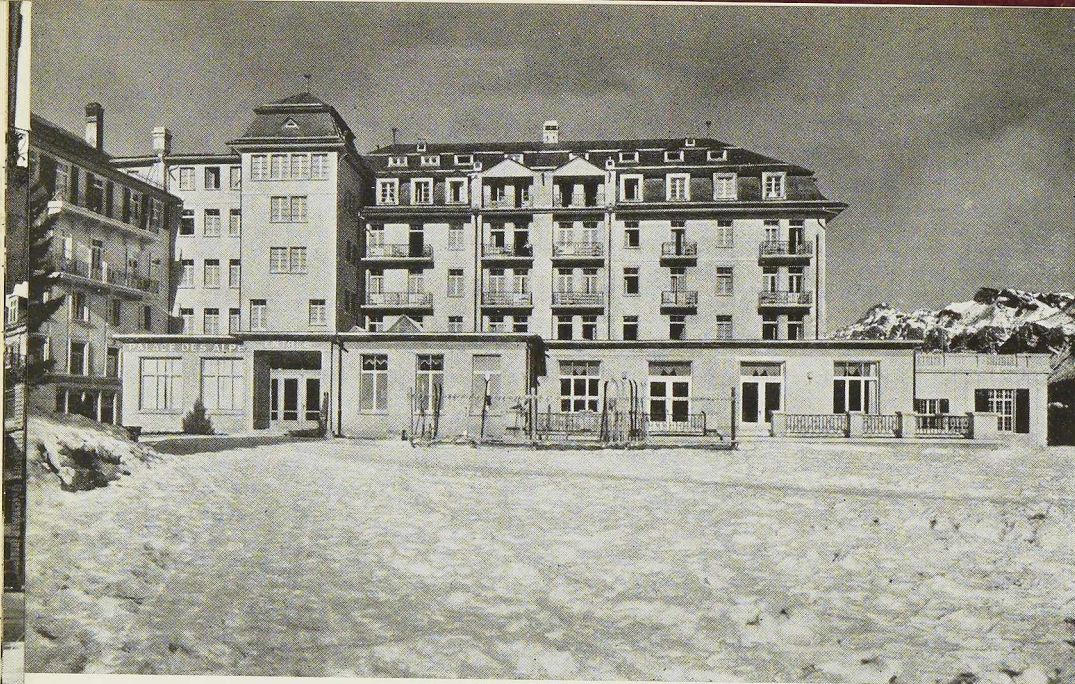
Fig. 105. L'Hôtel des Alpes à Mürren, canton de Berne. Surface bâtie : 460 mètres carrés. Poids de l'ossature métallique : 90 tonnes, soit 19 kg par mètre cube de bâtiment. La construction à ossature métallique fut adoptée parce qu'elle permettait une reconstruction rapide de l'ancien hôtel incendié et la réalisation d'une excellente isolation contre le froid et les bruits.
