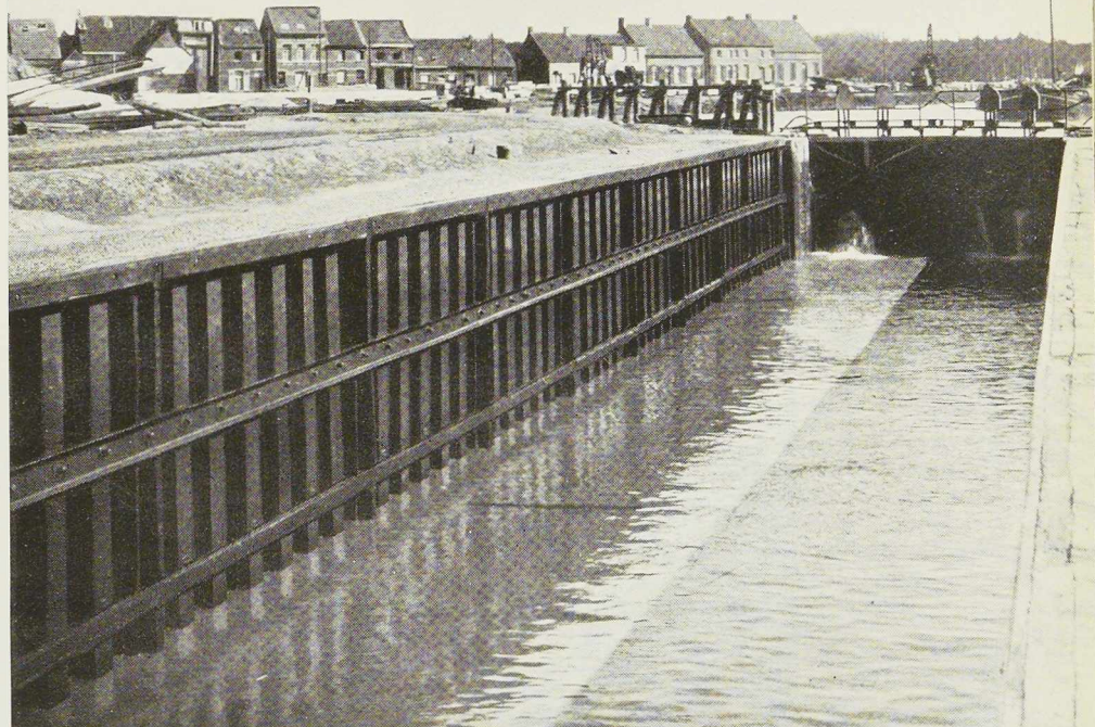
Fig. 96. Vue du sas montrant les bajoyers métalliques, et les portes métalliques busquées de la tête amont.
