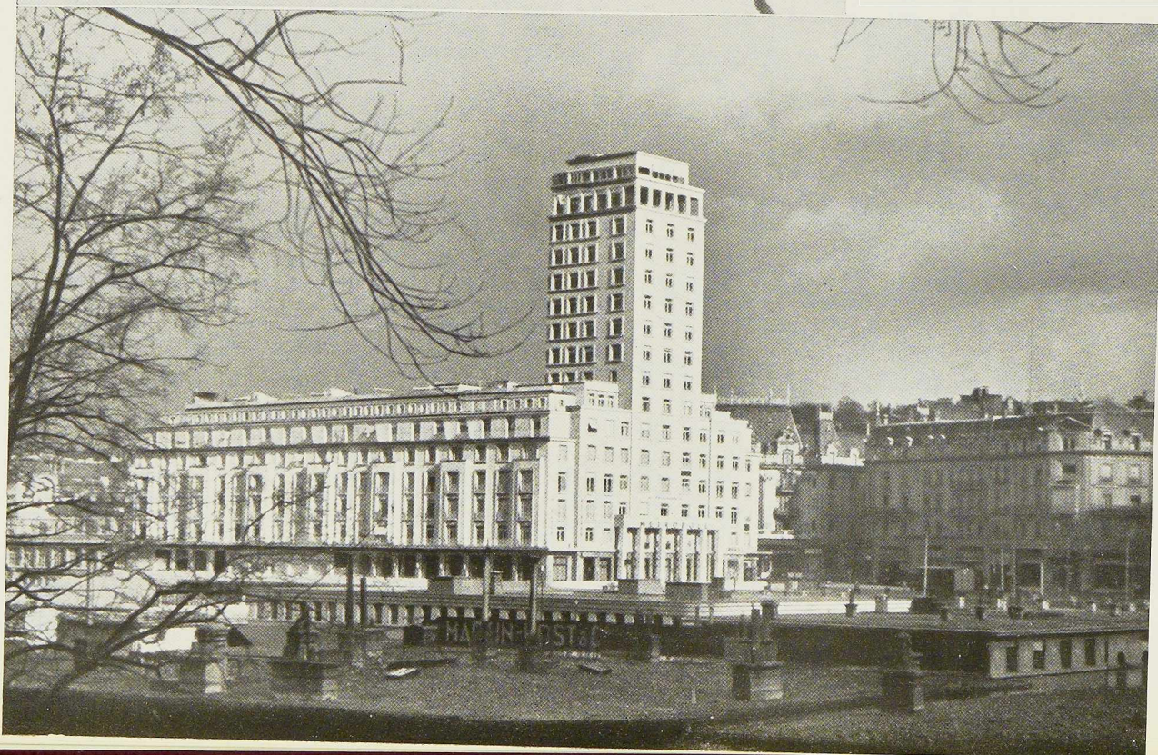
Fig. 119 et 120. Le bâtiment Bel-Air Métropole à Lausanne, le premier gratteciel de Suisse. Surface bâtie 3.800 mètres carrés, hauteur 66 m 70, volume bâti 120.000 mètres cubes. L'ossature métallique a été entièrement soudée, tant à l'atelier que sur le chantier. Tonnage d'acier 2.100 tonnes, soit 17,5 kg par mètre cube de bâtiment.
