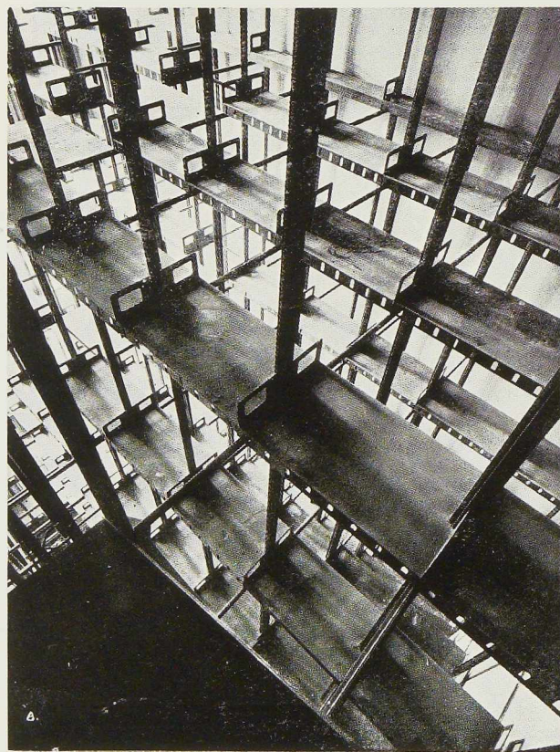
Fig. 87 et 88. Les rayonnages métalliques du dépôt de livres montent sans interruptions horizontales à travers la tour de 20 mètres de hauteur.
