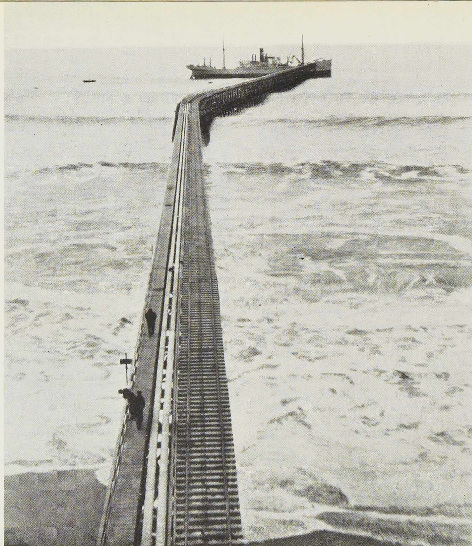
Fig. 64. Vue générale de l'estacade de 710 mètres de longueur. On aperçoit les deux grosses conduites servant au transport du ciment.
