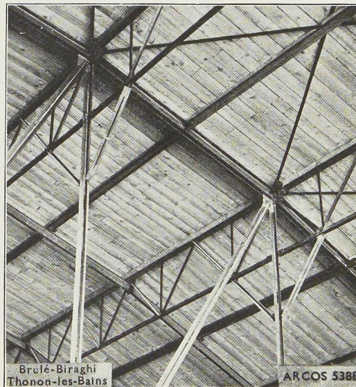
Fig. 63. Vue montrant les détails des arbalétriers et des pannes.
