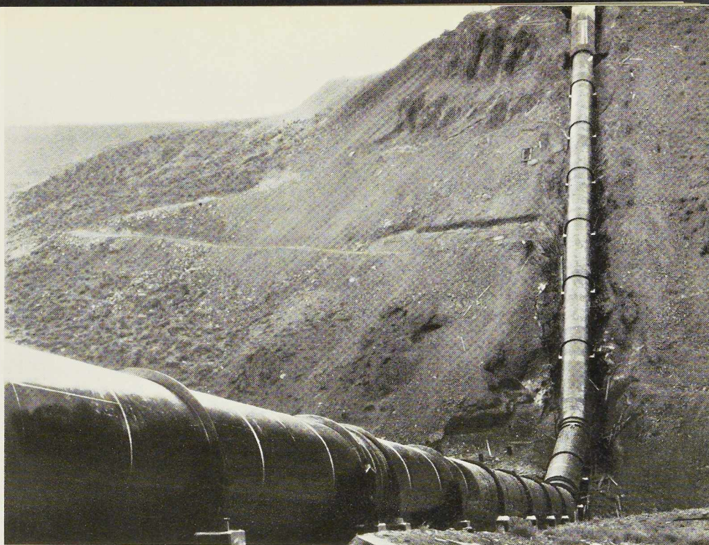
Fig. 16. Une partie de la conduite de 500 mètres de longueur et de 2 m 75 de diamètre. L'inclinaison de la conduite atteint 42 degrés.
