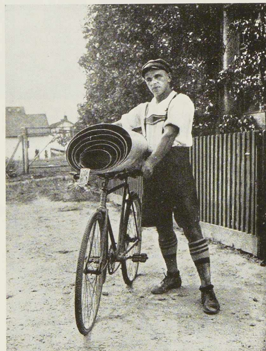
Fig. 21. Le transport des éléments constitutifs d'un pylône est des plus aisés et peut se faire à dos d'homme.
