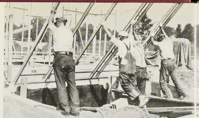
Fig. 8. Mise en place des panneaux des murs du rez-de-chaussée.
