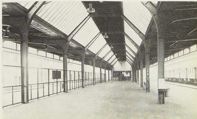
Fig. 645. L'auvent du quai III est porté par des fermes à deux montants.
