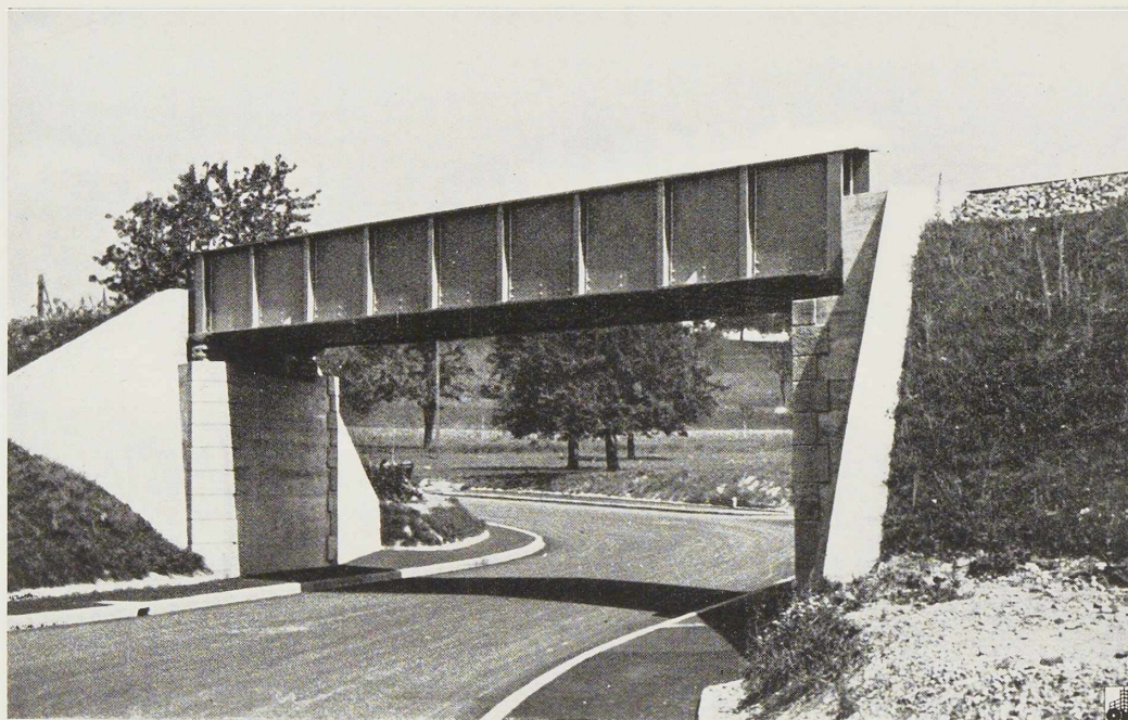
Fig. 624. Le pont soudé de la Seetalbahn près de Reinach.
