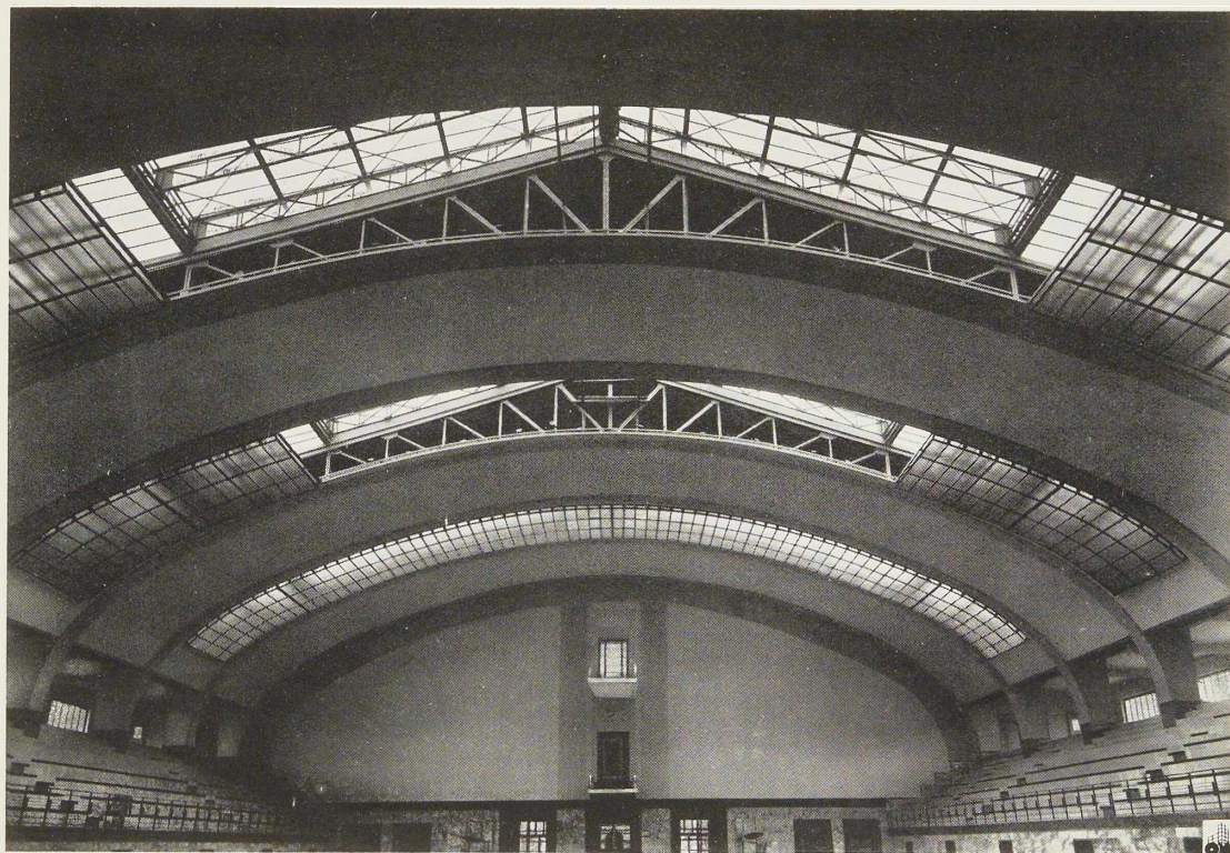
Fig. 623. Vue de la voûte : les châssis vitrés inférieurs des lanterneaux sont ouverts, les châssis supérieurs sont restés fermés.
