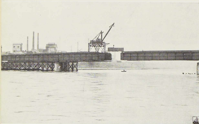
Fig. 640. Pose des derniers panneaux de l'âme de 15 mètres de longueur. Le porte-à-faux atteint 52 m 50. La grue de montage se déplaçait sur deux rails fixés au-dessus des poutres principales.
