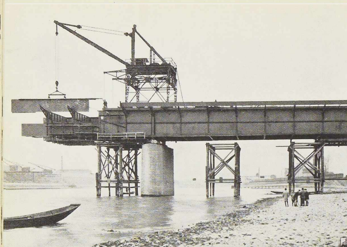
Fig. 639. Le début du montage de la travée centrale en porte-à-faux.
