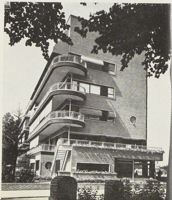
Fig. 614. La façade arrière et ses grands balcons.
