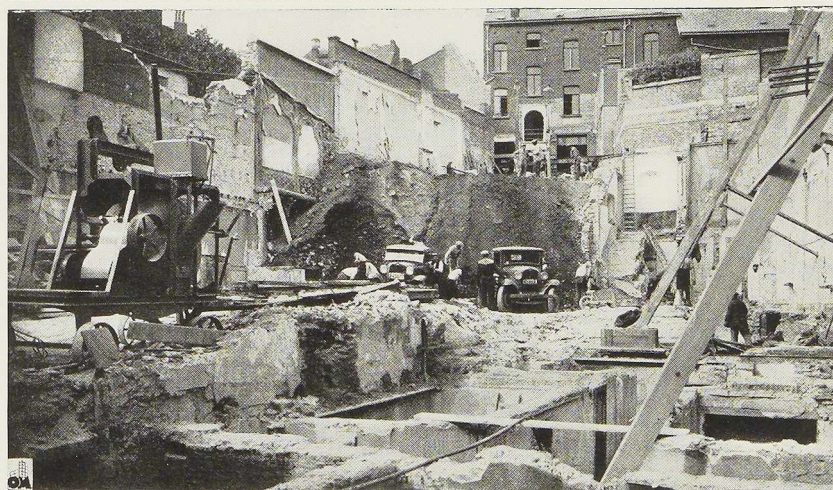
Fig. 545. Phase des travaux de déblaiement. Dans le fond: l'immeuble de la rue du Palais, qui sera aménagé pour la réception des marchandises.
