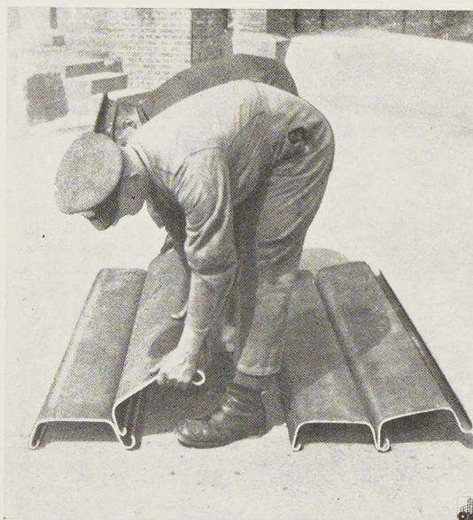
Fig. 572. L'assemblage des éléments se fait par simple agrafage.
