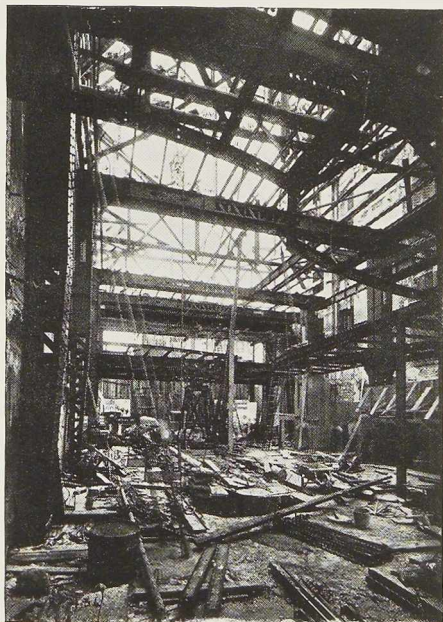
Fig. 534. Vue prise à l'achèvement du montage de l'ossature de la brasserie.
