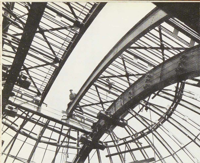
Fig. 492. Les grands volets coulissant de la coupole en position entr'ouverte. L'espace libre qu'ils découvrent a une largeur de 4 m 90 et va de la base jusqu'à 2 m 75 au delà du sommet de la coupole. Grâce aux contre-poids équilibrant ces volets pesant 16 tonnes, les manœuvres d'ouverture et de fermeture se font rapidement avec un moteur de 2 CV seulement.
