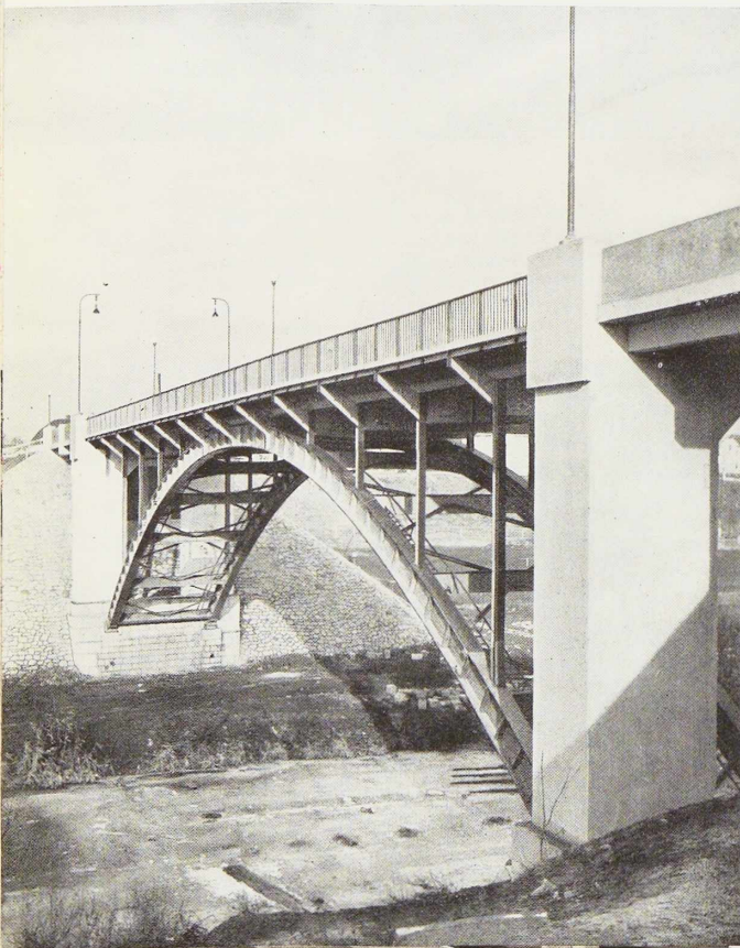
Fig. 495. Vue d'ensemble d'un pont en arc entièrement soudé à Pilsen.
