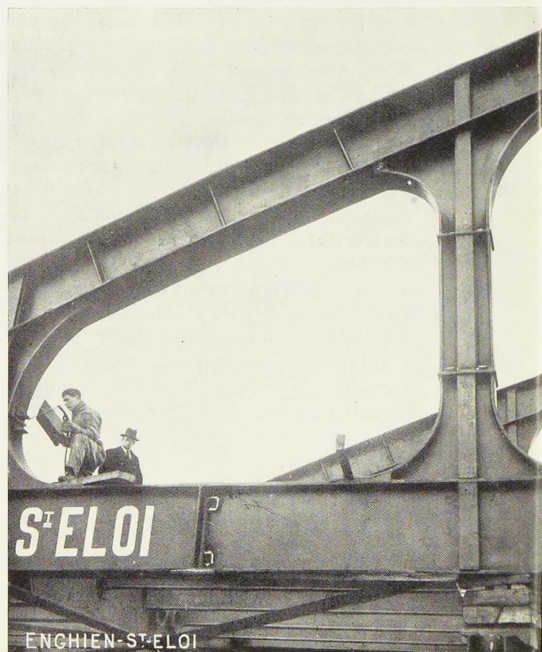
Fig. 445. Détail d'un des longerons. On remarque les plats transversaux disposés dans le montant au droit des joints à réaliser sur chantier. Ces plats, soudés en atelier sur la section supérieure d'about de la pièce à assembler, évitent entièrement toutes soudures au plafond lors du montage. La bride inférieure de la poutre Vierendeel est une poutrelle GREY DIE 850, la bride supérieure est une poutre soudée composée d'une âme de 670 \times 11,5 et de semelles de 500 \times 29 .
