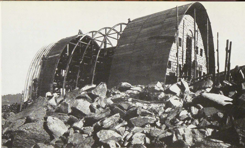
Fig. 485. Placement de la couverture en madrier sur l'ossature métallique.
