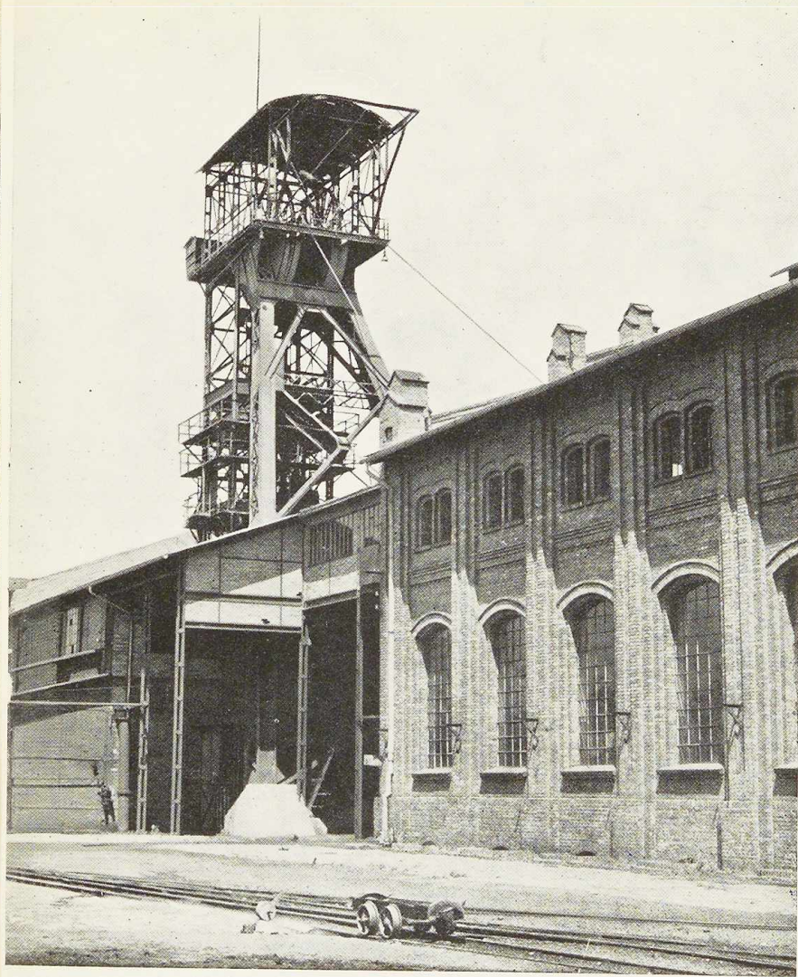
Fig. 465. Vue générale du chevalement.
