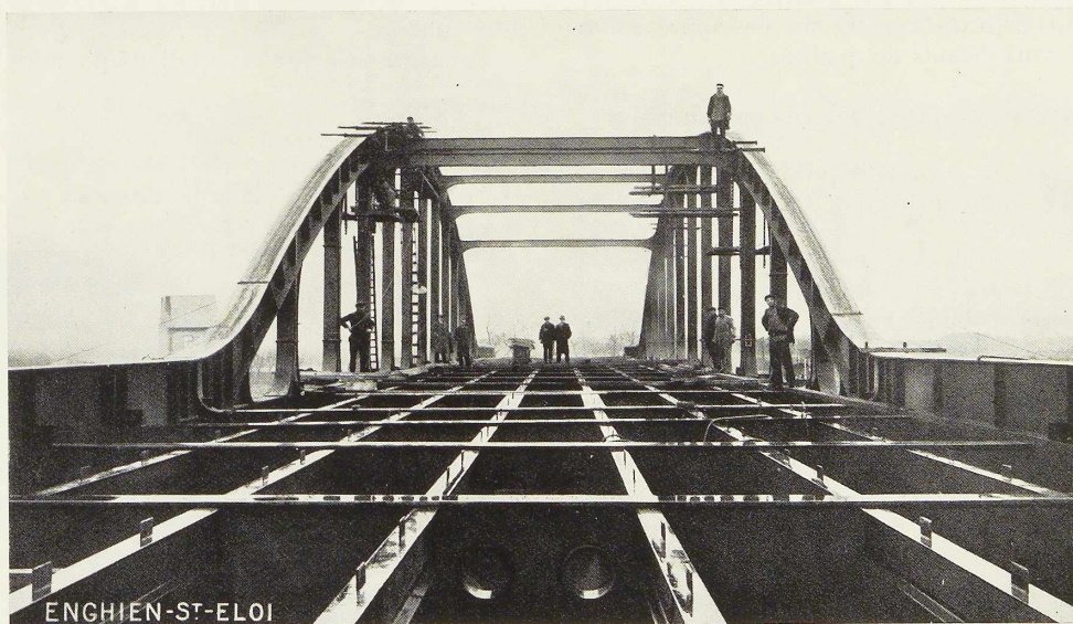
Fig. 446. Vue du pont prise d'enfilade, à l'achèvement du montage. Les pièces du pont sont des poutrelles GREY DIE 850. Les plats soudés de champ sur les longrines sont destinés à servir d'ancrage à la dalle en béton armé supportant la chaussée.
