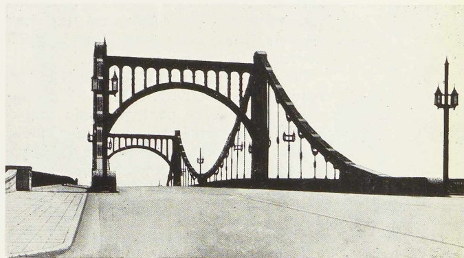
Fig. 397. Vue d'enfilade du pont de Kiyosu sur le fleuve Sumida à Tokyo. C'est un pont suspendu, à chaînes de suspension, dont la travée principale mesure 91 m 40 et les travées latérales 45 m 70. Les portiques du pont sont du type Vierendeel.
