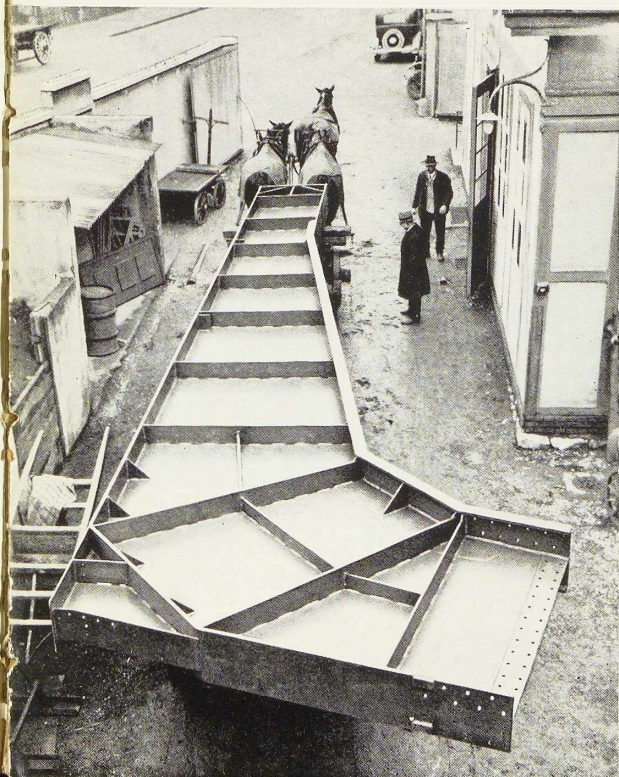
Fig. 403. Tronçon d'arc à 3 rotules, pendant le transport au chantier.
