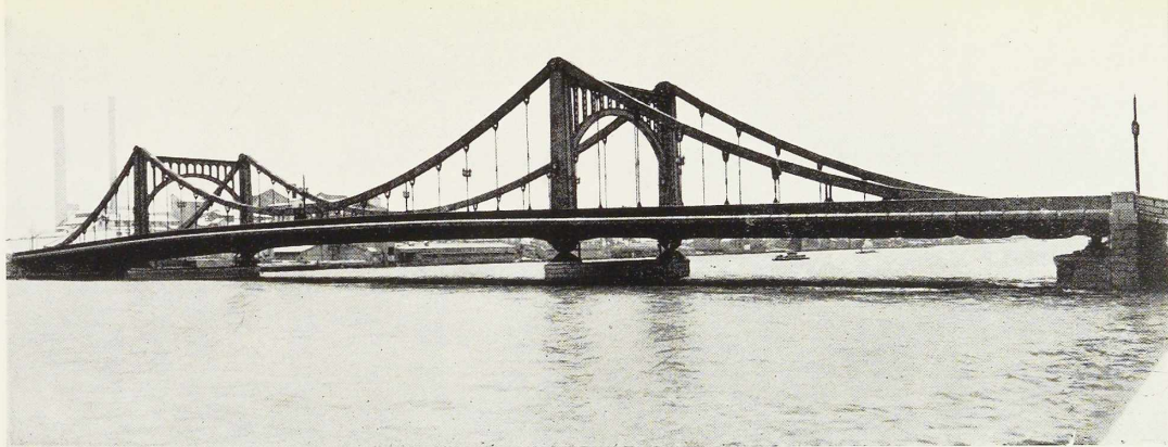
Fig. 396. Vue du pont de Kiyosu à Tokyo. Longueur totale 186 m 70. Hauteur des tours 20 m au-dessus du niveau des maçonneries des piles.
