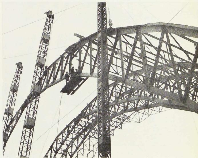
Fig. 334. 20 février 1934. Montage de la troisième ferme du cintre métallique.
