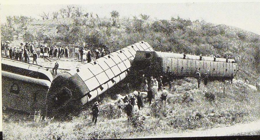
**Fig. 388.** Déraillement de voitures métalliques. Les voitures se sont couchées sur le talus du remblai. Aucun dégât à l'intérieur.
