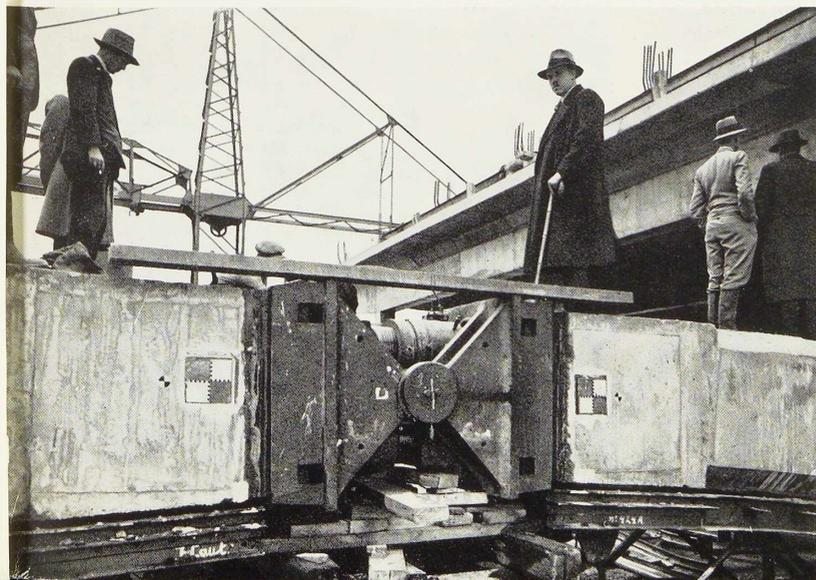
**Fig. 330.** 1<sup>er</sup> mai 1934. Vue de la rotule de clef d'un arc en béton armé et des vérins qui serviront au décentrement de l'arc, par écartement des deux moitiés de l'arc à la clef. (Les décentremments sont exécutés par la firme Cornet d'Ampsin.) (Photo W. Kessels.)
