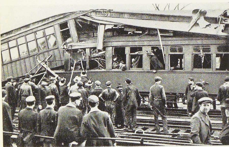
**Fig. 387.** Collision de trains composés de voitures en bois. La voiture de dessous, en pénétrant dans celle de dessus, a écrasé tout ce qui se trouvait à l'intérieur de celle-ci.
