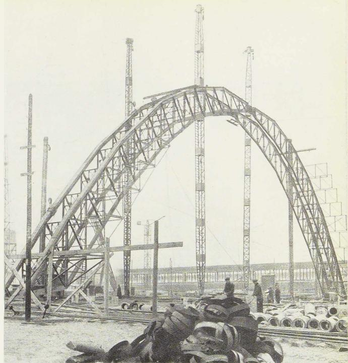
Fig. 333. 11 février 1934. Le montage des deux premières fermes du cintre métallique. On voit les six mâts de montage en place aux abords de la deuxième ferme. Dans la partie centrale les fermes ne sont pas encore entretoisées. (Photo Peeters.)
