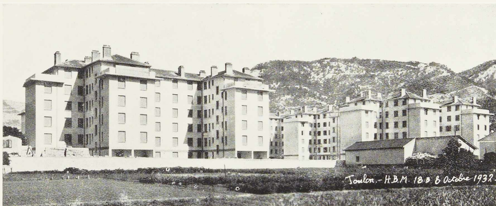
Fig. 275. Immeubles à Toulon, primés au Concours de l'O. T. U. A. Architectes : MM. Cargill et Bornand.
