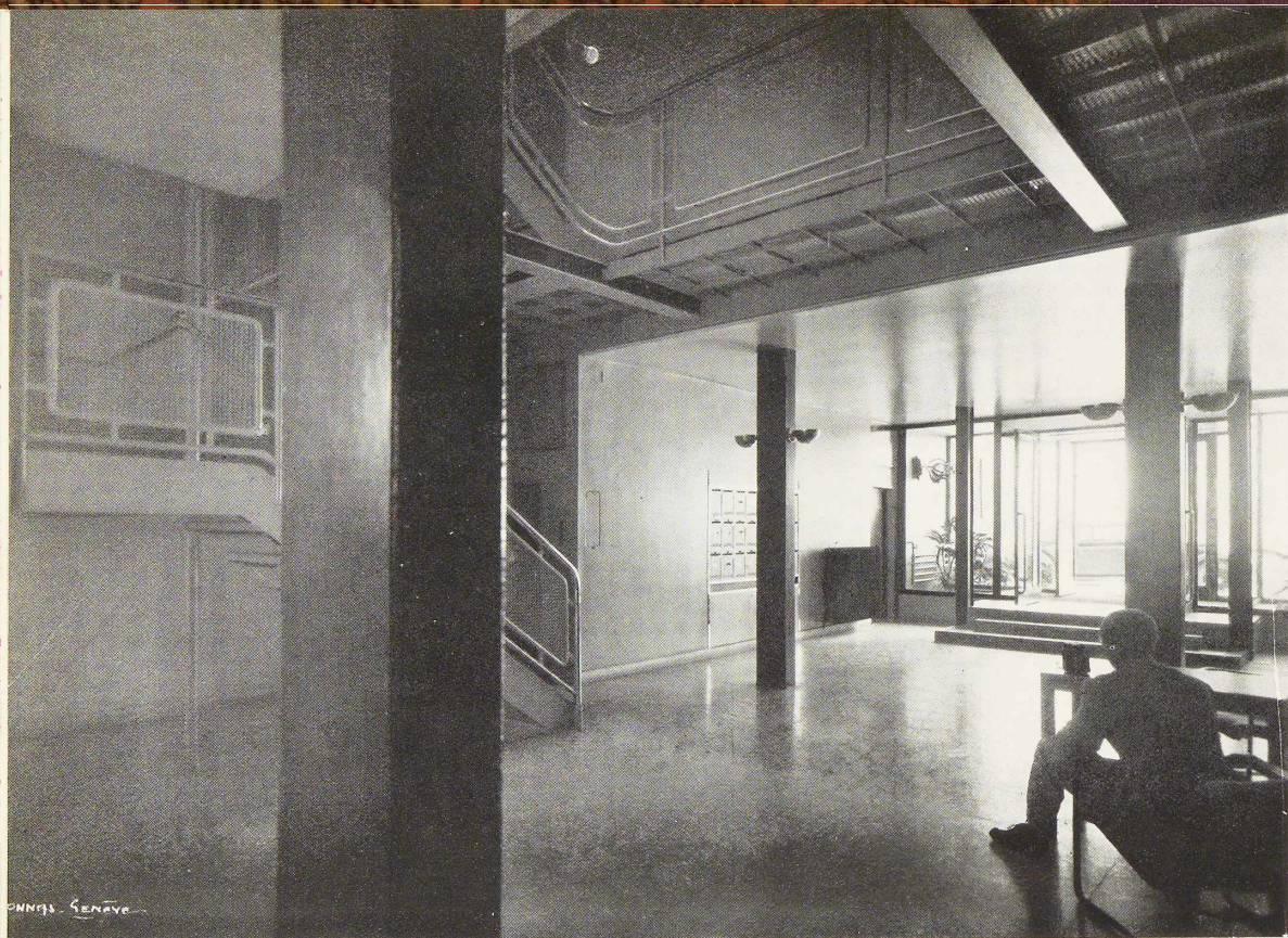
Fig. 262. Immeuble « Clar-té » à Genève. Vue du hall d'entrée. Construction apparente - escalier en verre et fer.
