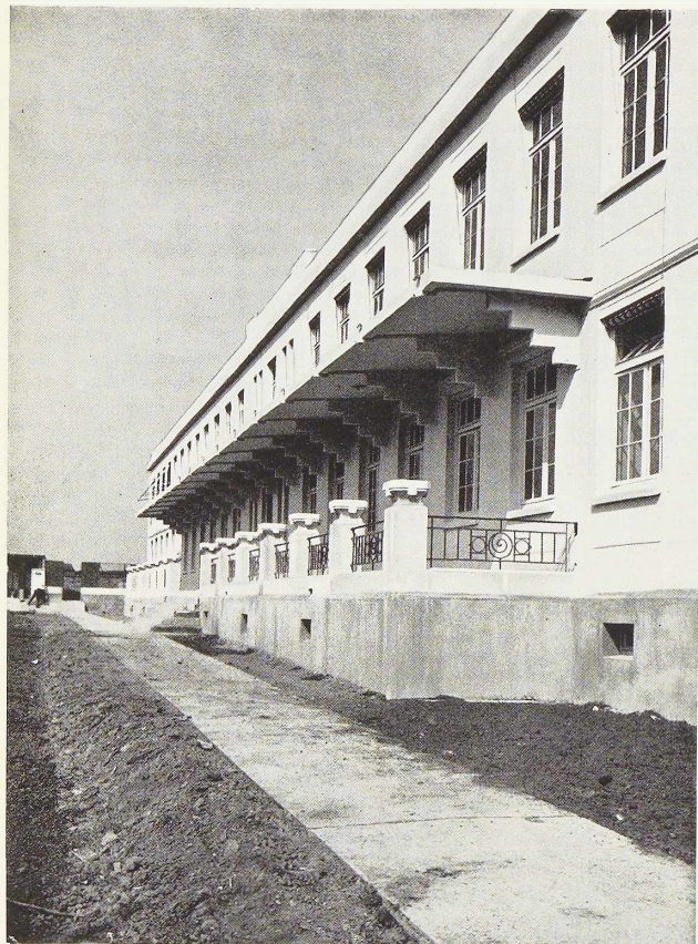
Fig. 277. Hospice à Villejuif, primé au Concours d'architecture de l'O. T. U. A. Entrepreneur : M. Fillod.
