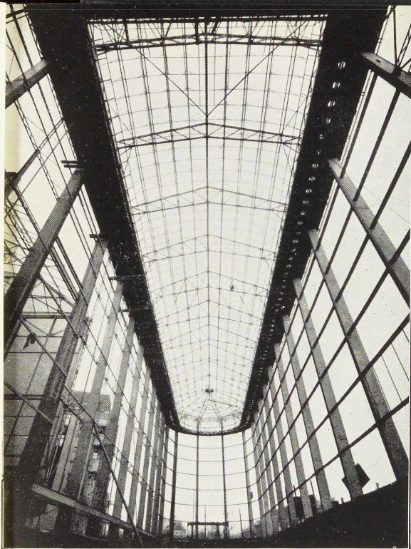
Une impressionnante perspective intérieure de l'ossature métallique du magasin d'exposition. Il s'agit d'une construction en verre et acier. Arch. Dumont et Van Gcethem. Entreprise Blaton-Aubert.
