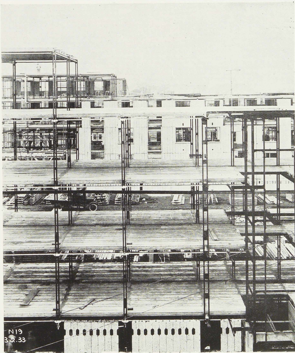
Fig. 188. Les hourdis en béton posés sur les solives métalliques de l'ossature sont immédiatement utilisés pour tous les travaux ultérieurs. (Cliché Chantiers.)
