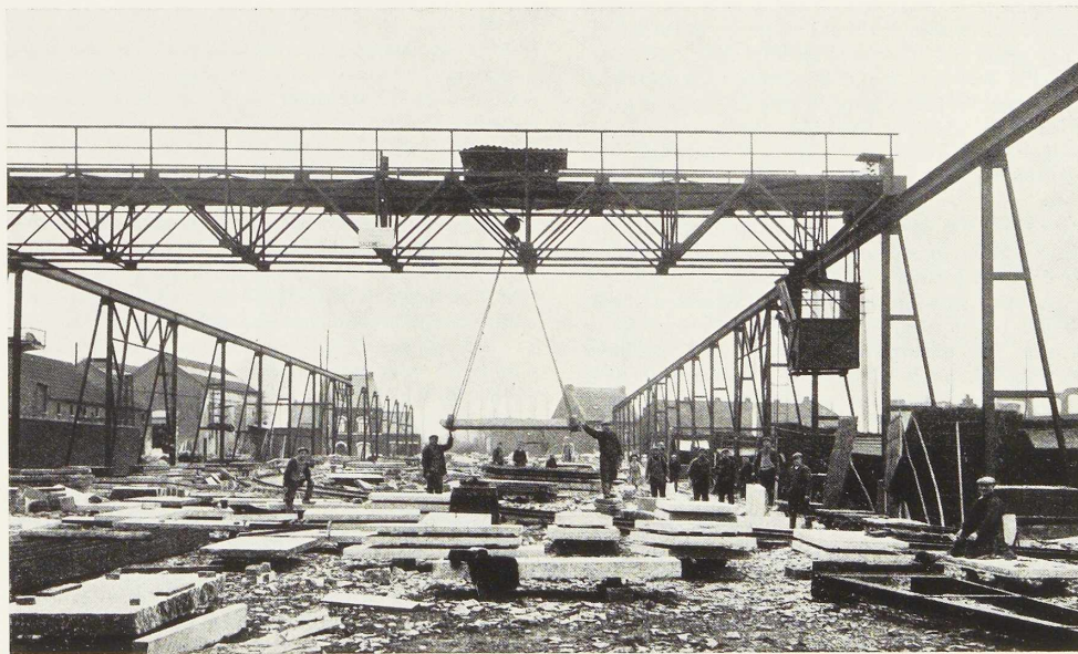
Fig. 209. Pont roulant desservant un chantier de la S. A. Gain Bongard à Maffles.
