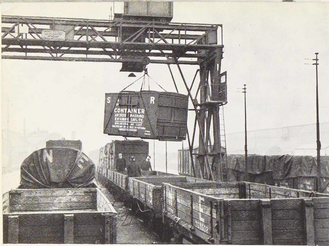
Fig. 136. Chargement de containers sur une rame de wagons au moyen d'un portique, dans une gare du Southern Railway.
