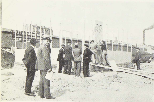
Fig. 86. Le montage de la maison Grames dure 48 heures.
