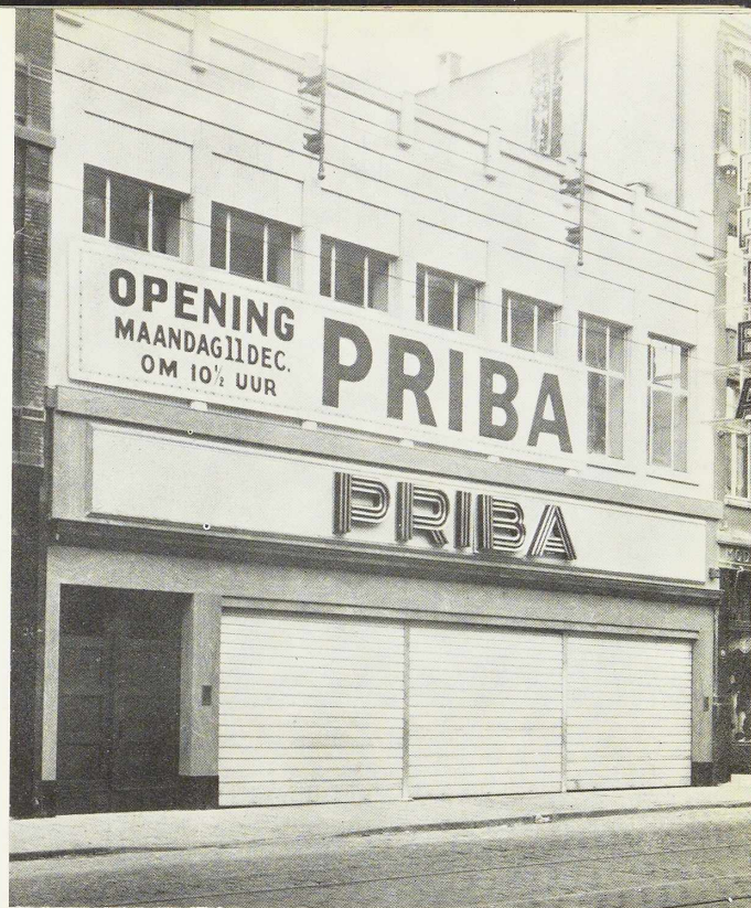
Fig. 68. Le nouveau magasin « Priba » à Anvers. Vue de la façade. Photo prise le 9 décembre 1933.
