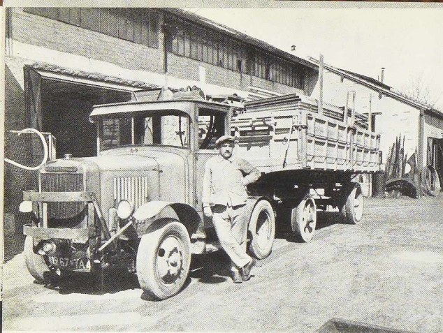
Fig. 85. Un seul camion transporte la maison métallique Grames de quatre pièces.
