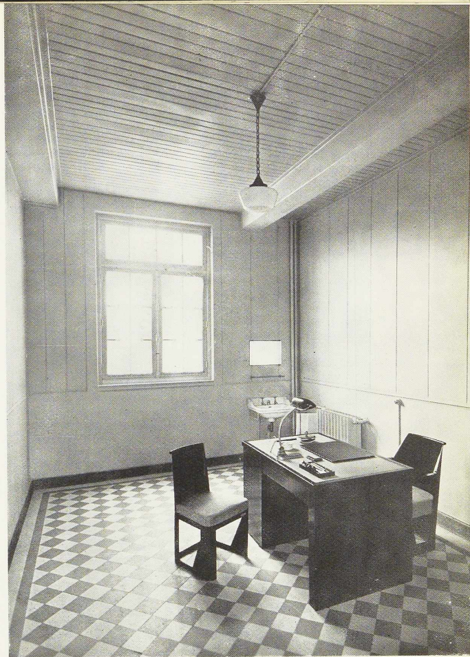
Fig. 97. Un bureau dans une construction métallique Fillod. On voit la façon dont est constitué le plafond.
