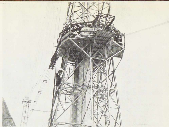
Fig. 101. Voie de retour des wagons suspendus. Dans cette partie du trajet les wagons sont mus par moteurs électriques. Deux wagons peuvent être garés dans la courbe.
