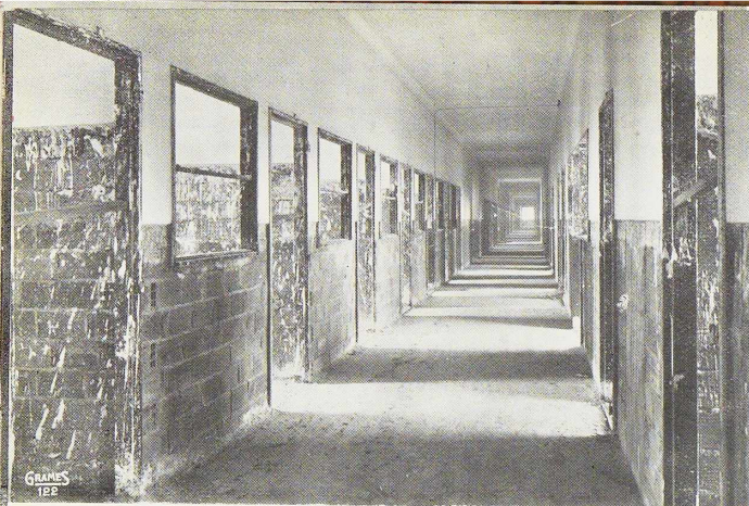
Fig. 91. Vue d'un couloir du nouvel hôpital Beaujon après la pose des chambranles métalliques. Toutes les portes de cet hôpital sont des portes métalliques Grames.
