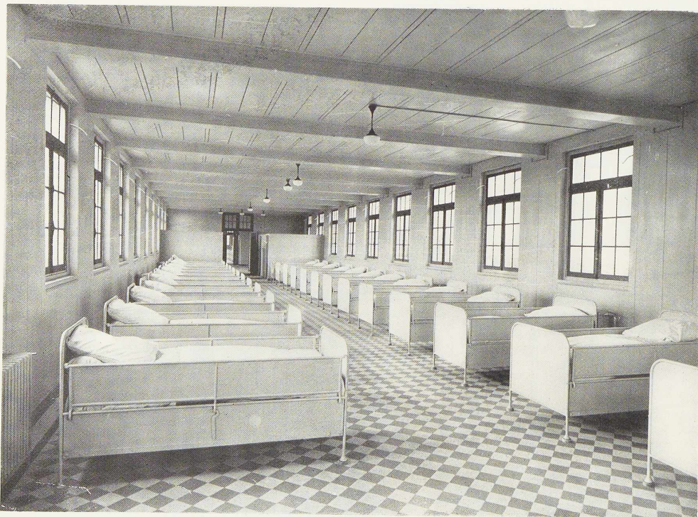
Fig. 96. Vue intérieure d'une construction métallique Fillod. Un dortoir de l'hospice de Villejuif.
